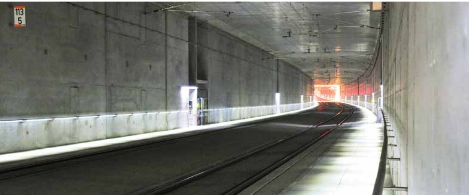
Handlauf mit integrierter Beleuchtung im Burgstaller Tunnel
