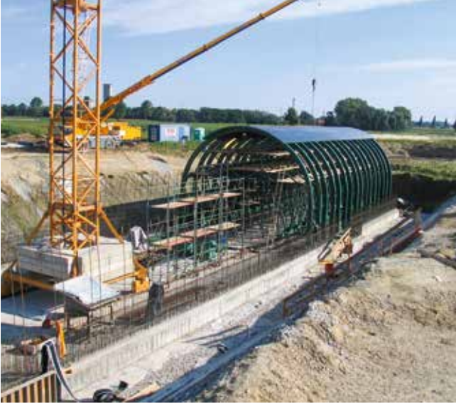
Offene Bauweise mit Schalwagen
