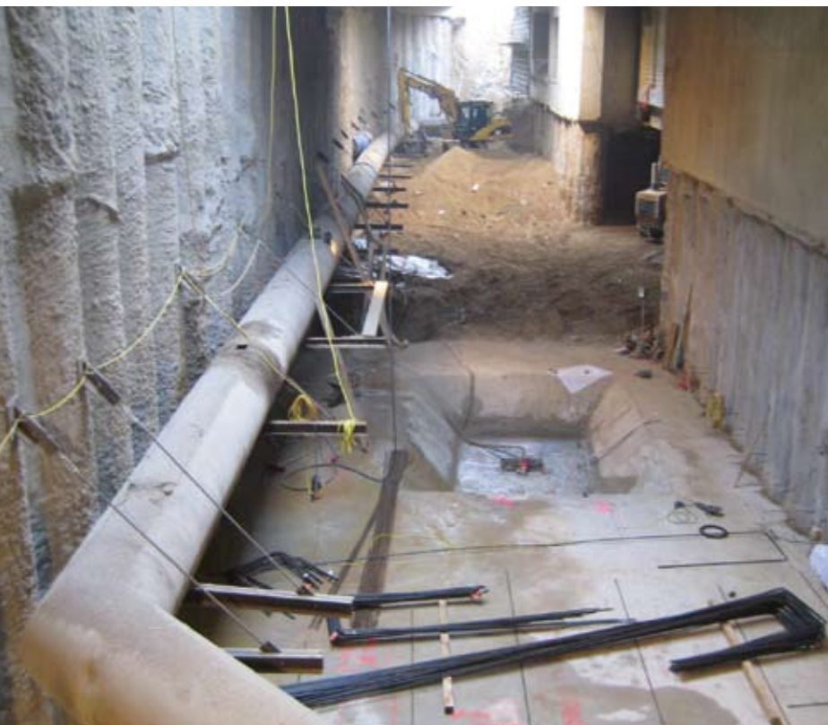
Passagenbauwerk mit Bypass an südseitiger Bohrpfahlwand
