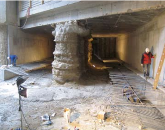
Schließung der Rahmenkonstruktion nach Durchstich der Fußgängerpassage
