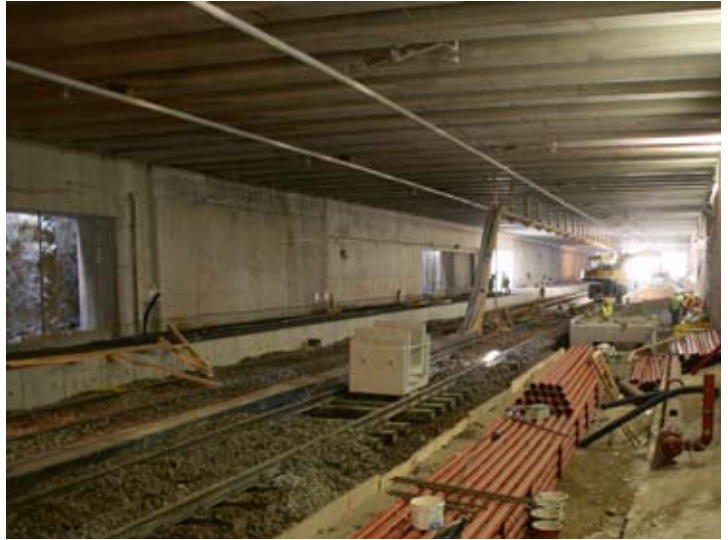
Verlängerte Bahnsteige mit neuen Bahnsteigkanten und Einbauten
