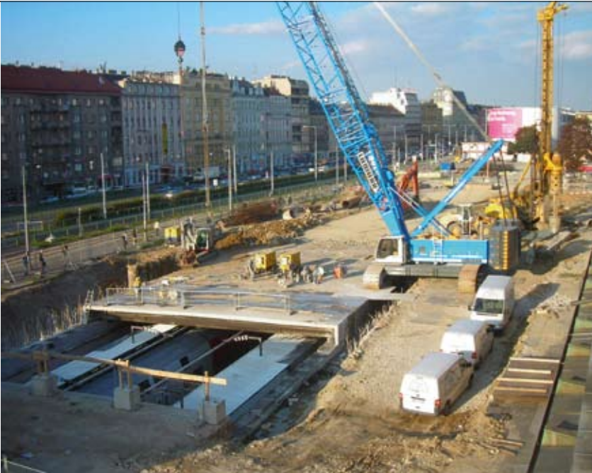
Offene Schnellbahnhaltestelle während des Deckentausches
