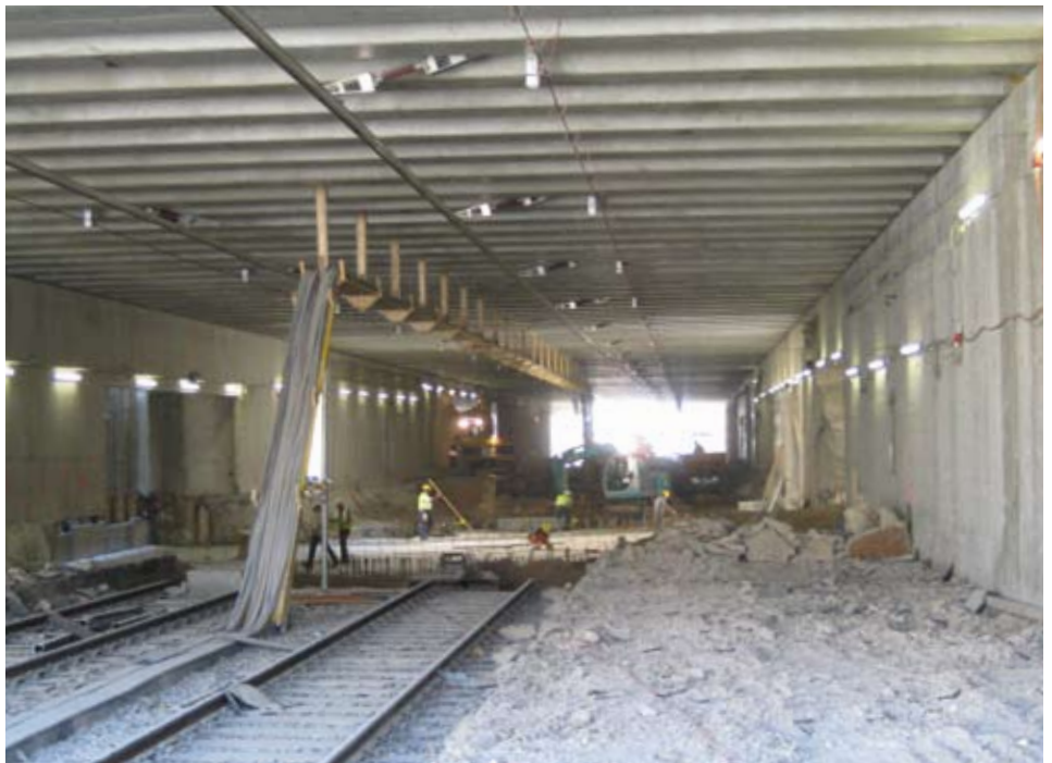
Neue Tunneldecke aus Fertigteilträgern mit provisorischer Kabelaufhängung
