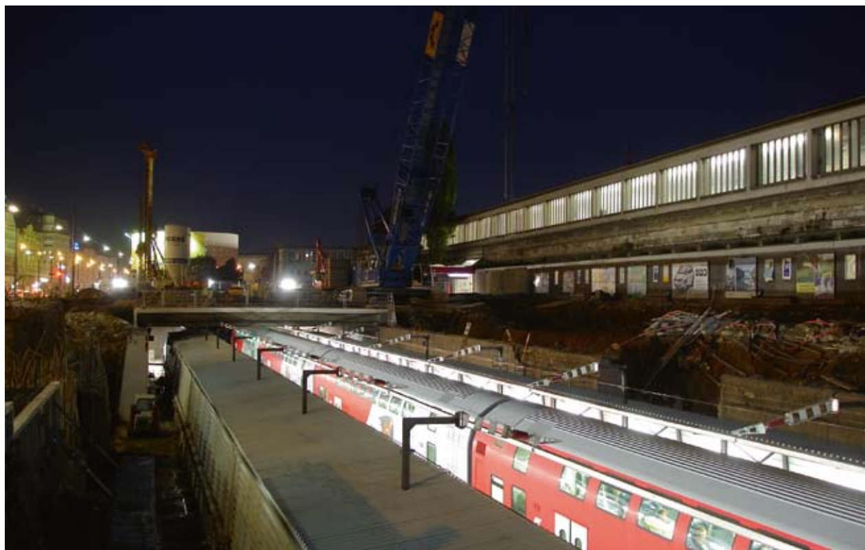
Nachteinsatz zum Ausheben der Deckenträger
