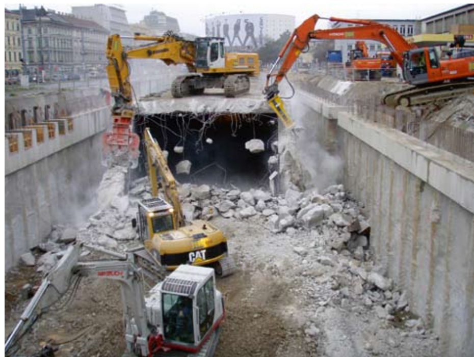
Abbruch des Schnellbahntunnels zur Verlängerung der Haltestelle
