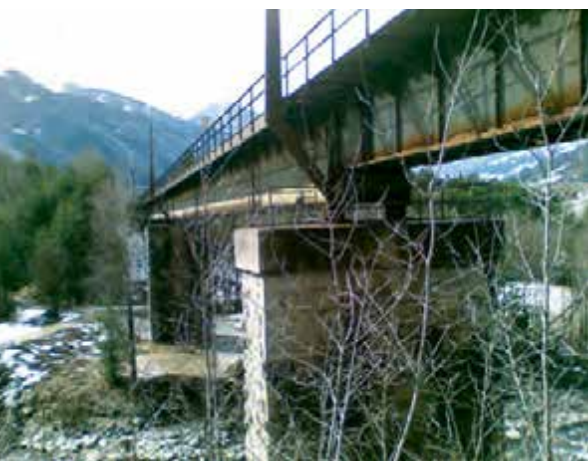
Bestandsbrücke aus dem Jahre 1968
