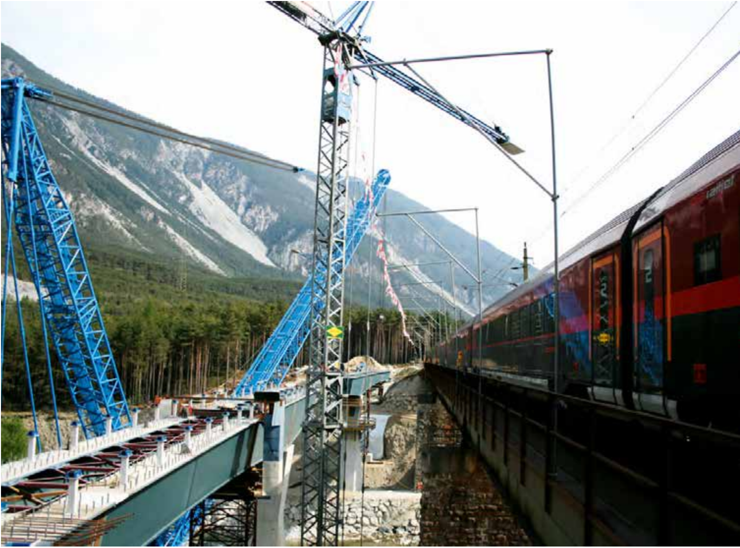
Montage des Stahlhohlkastens neben der in Betrieb befindlichen Strecke
