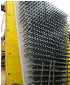
Biegesteifer Anschluss Pfeilerkopf – Stahlhohlkasten
