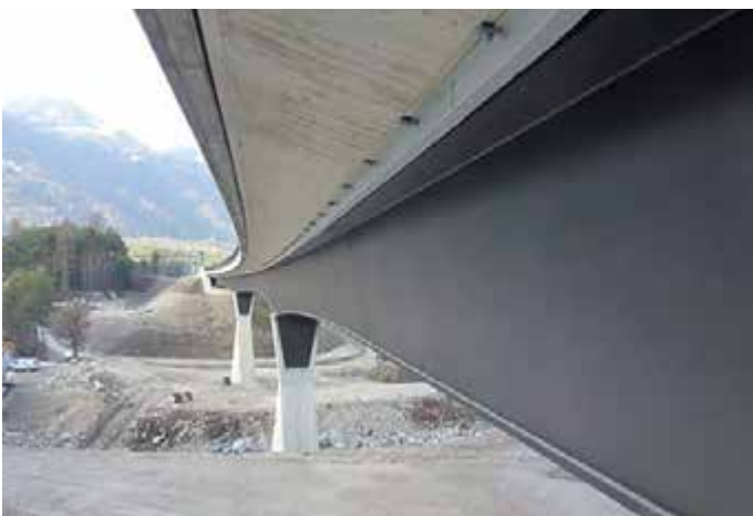
Fertiggestellte Öztaler Achsbrücke der 4. Generation, Untersicht
