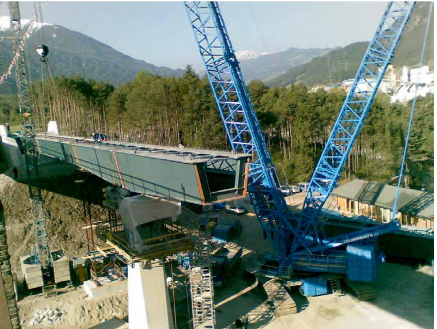
Montagevorgang Stahlhohlkasten, Mobilkran LR 1600 mit 600 t Tragkraft
