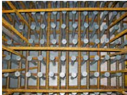
Biegesteifer Anschluss Pfeilerkopf – Stahlhohlkasten
