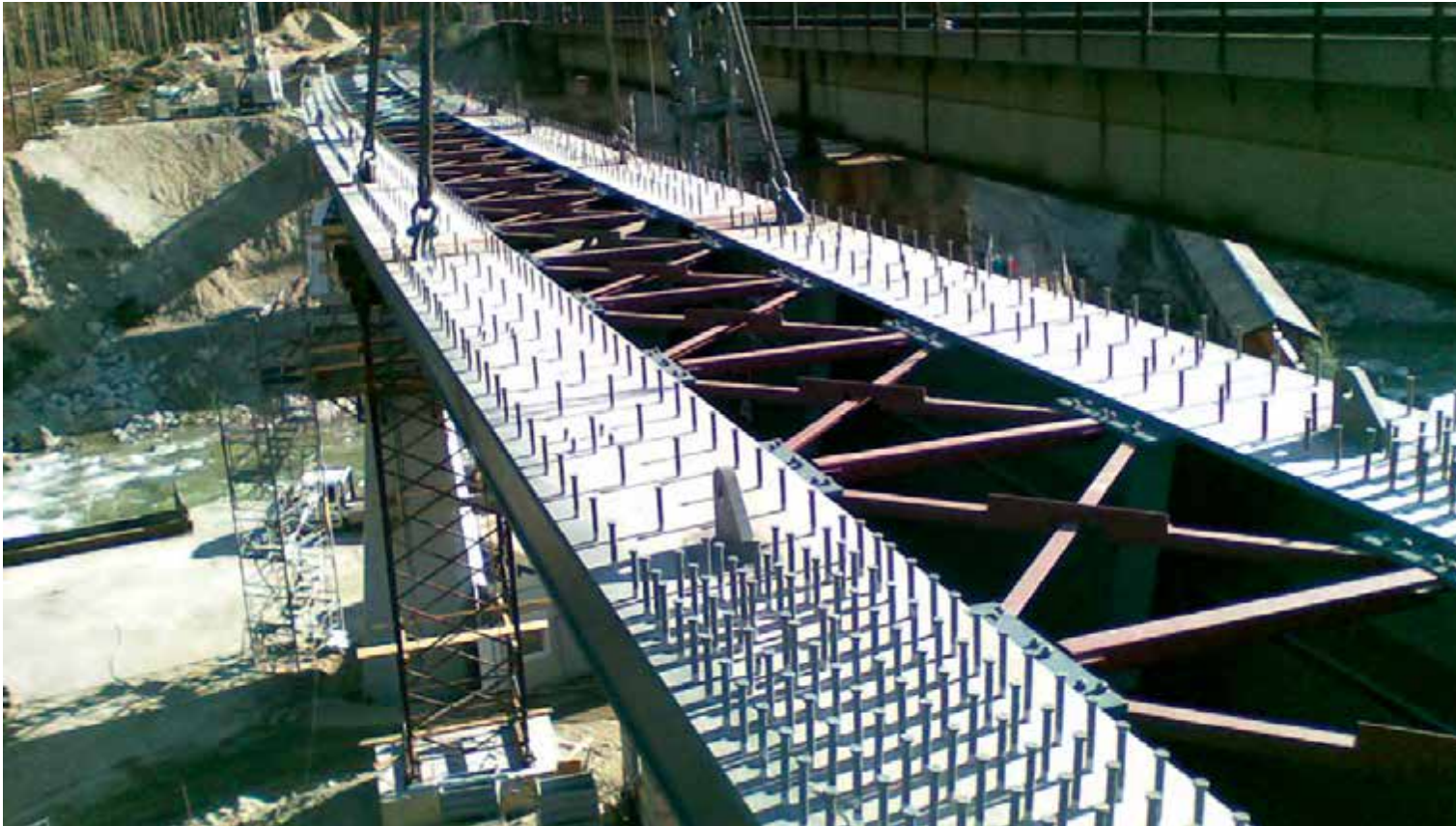
Draufsicht Obergurt des Stahlhohlkastens mit Montageverband und Kopfbolzendübel
