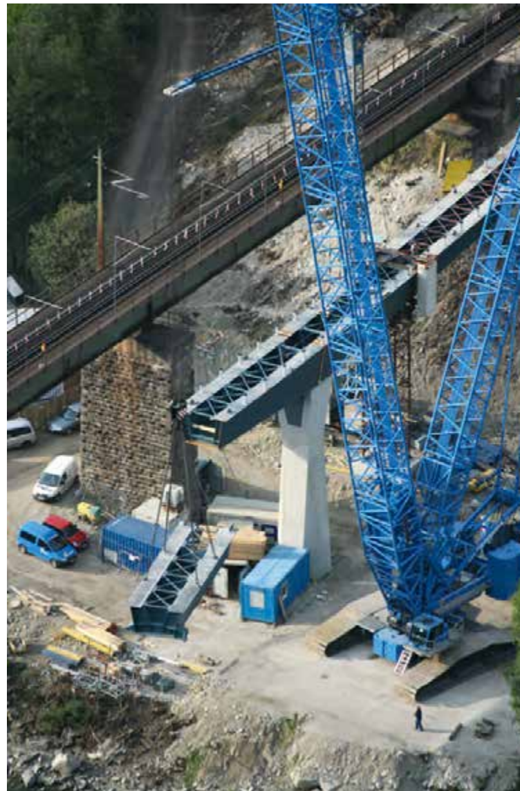
Montagevorgang Stahlhohlkasten, Luftbild
