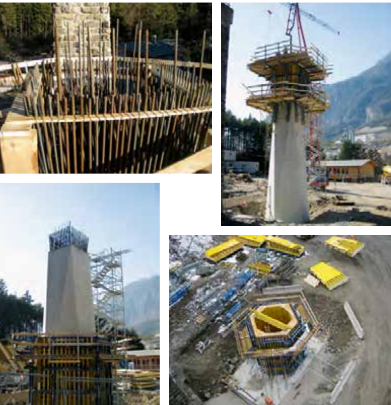
Pfeilerschaft aus Stahlbeton
