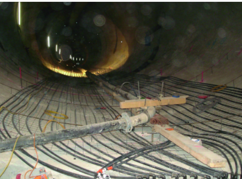
Abb. 2: Energiebodenplatte im Baulos U2/2 der Wiener U-Bahn Foto: © J. Hofinger, ic-Consultanten ZT GmbH
