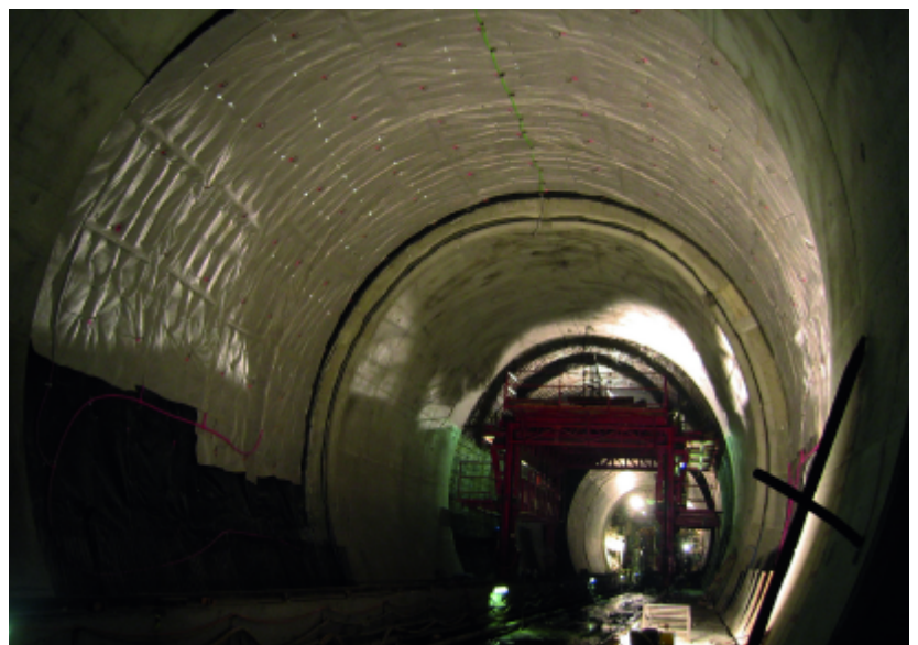
Abb. 1: Energievlies-Prototyp im Lainzer Tunnel, Baulos LT 22 Foto: © R. Markiewicz, Geotechnik Adam ZT GmbH
