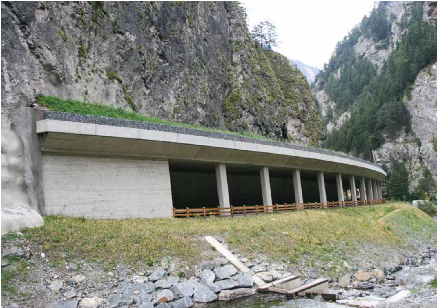
Übergang Galeriebauwerk – Naturtunnel
