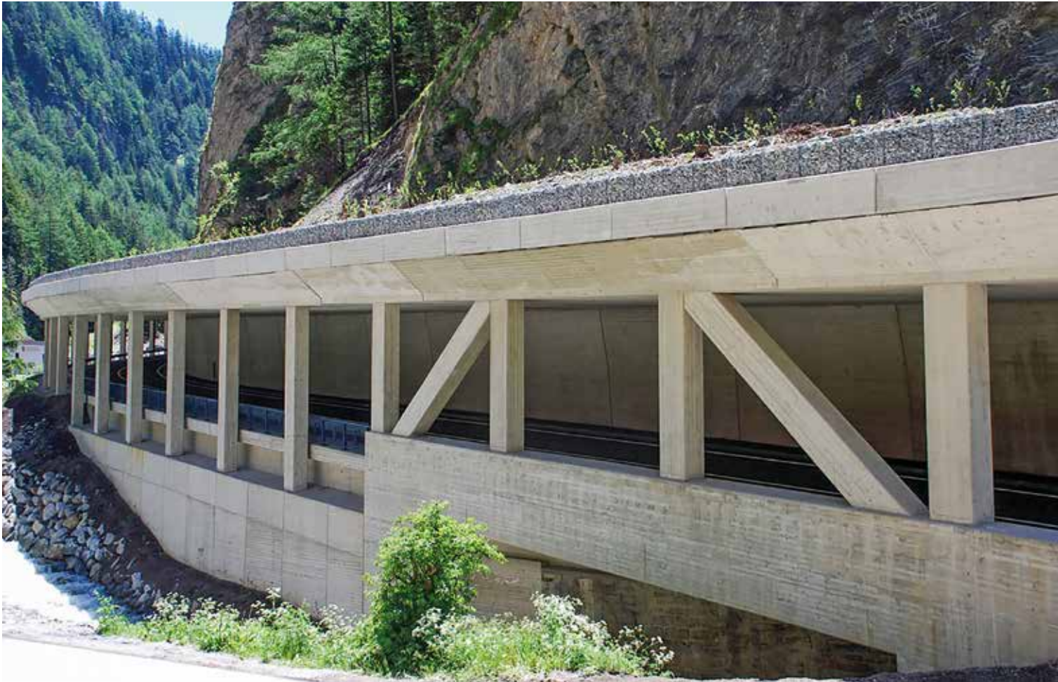
Überbauung Stillerbachbrücke mit Sprengwerk
