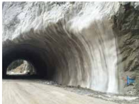
Naturtunnel – aufgeweitet und gesichert
