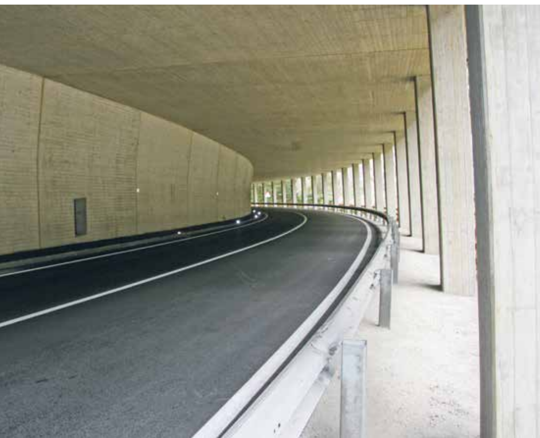
Straße – Fahrraum Galeriebauwerk
