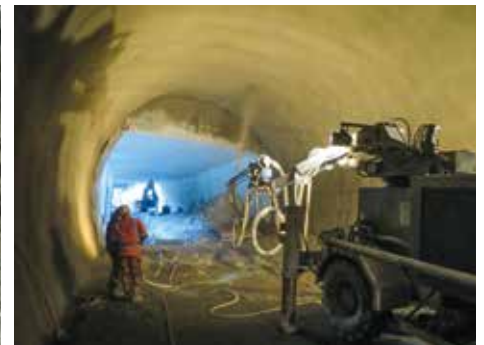
Innenauskleidung – Spritzbetonschale Naturtunnel
