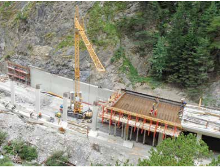
Herstellung Galerietragwerk
