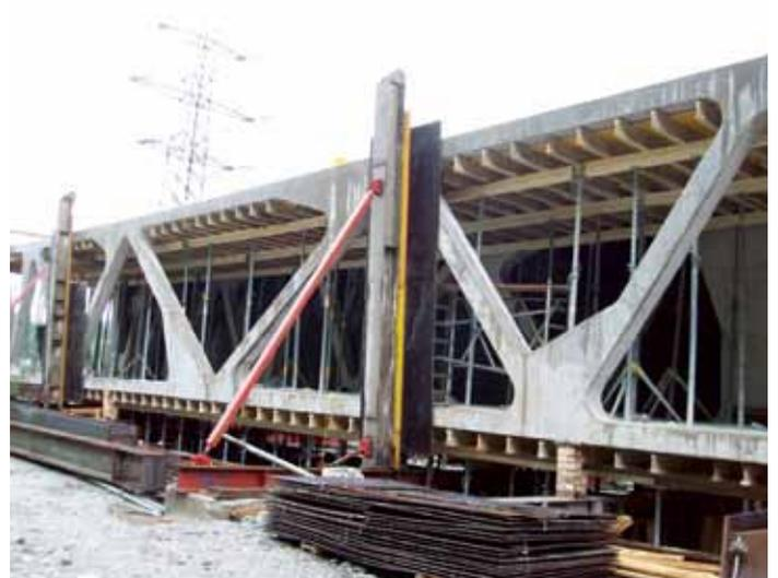
Betonage der Decke und der Fahrbahnplatte
