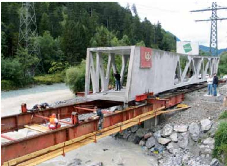
Einschub der Brücke mittels Seilwinde
