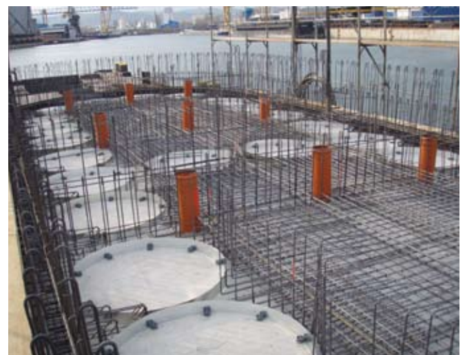
Basiselement: Herstellen der Bodenplatte
