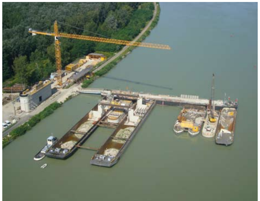
Herstellen der Gründungskörper der Strompfeiler Nord und Süd
