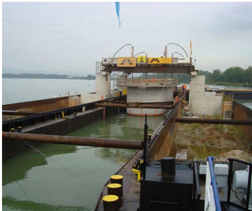
Einschwimmen Pfeiler Nord
