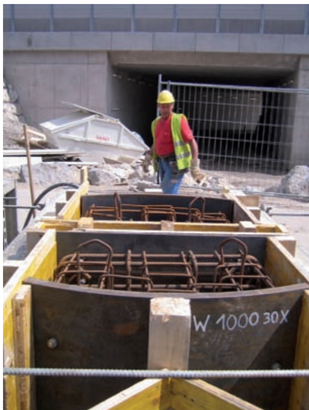
Abb.1: Herstellung der Wälz Gelenke
