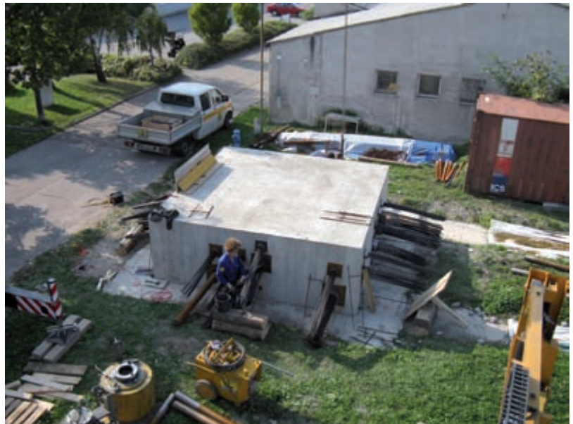
Abb. 3: Betonblock mit umgelenkten Spanngliedern
