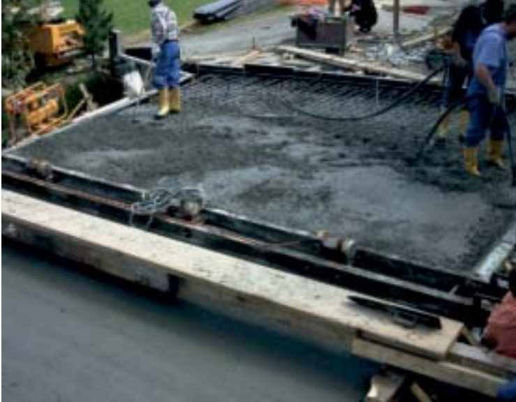
Bild 11: Landfraßbrücke STW 7 m, Tragwerk mit Hochleistungsbeton, keine Randbalken; Detailprojekt: Amt der Kärntner Landesregierung, Abt. 17, Brückenbau; DI Volker Bidmon
