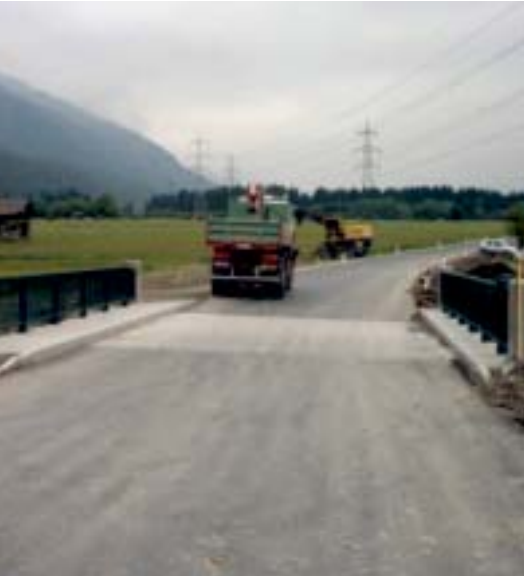
Bild 9: Das Ergebnis – eine exakte, geschlossene und rissfreie Oberfläche der Fahrbahnplatte
