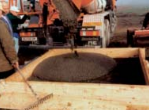
Bild 3: Erste Probebetonierung
