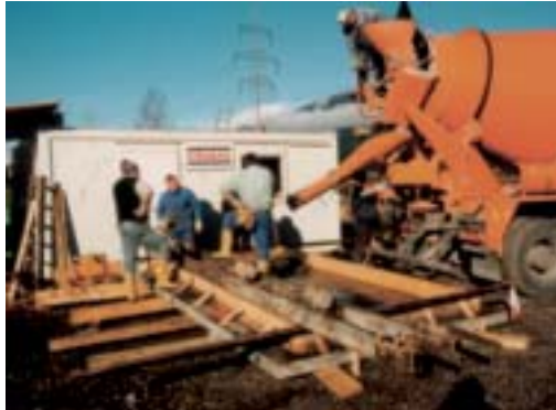
Bild 4 + Bild 5: zweite Probebetonierung
