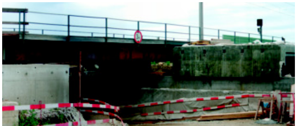
Abb. 3: Tragwerk vor dem Einschub
