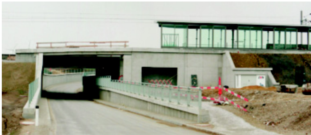
Abb. 1b: Neu: Umbau als Landesstraßenunterführung mit Haltestellenfunktion
