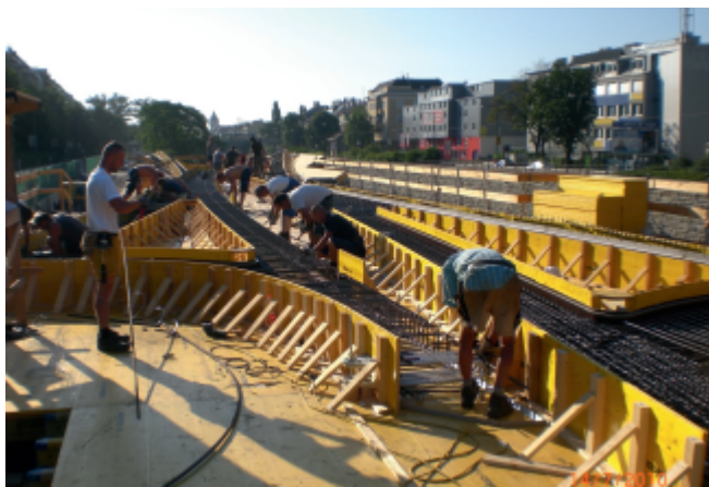
Herstellung der rund 40 m langen Hauptträger
