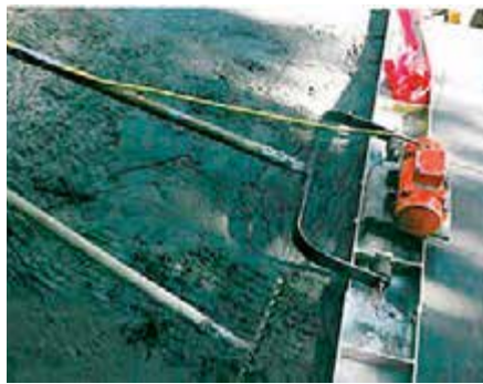
Einbringen der 3 cm dicken UHFB-Schicht
