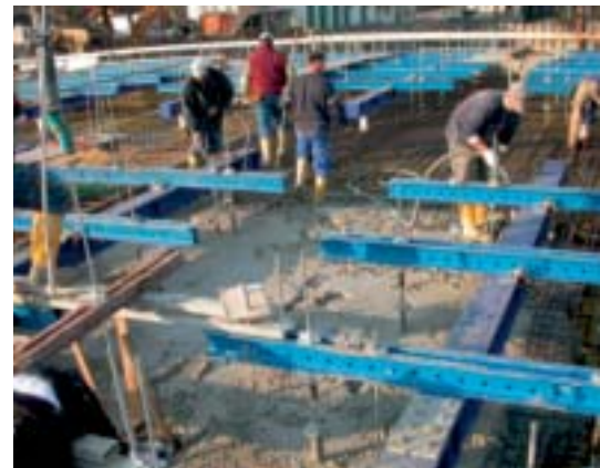
Abb. 6: Betonierung Verbundplatte
