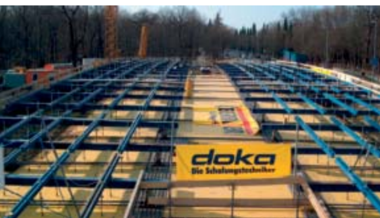
Abb. 7: Tragwerksschalung
