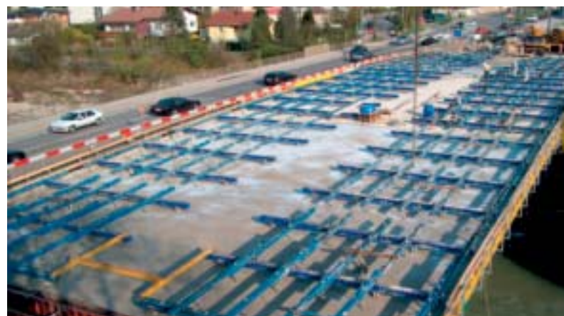
Abb. 8: Verbundplatte nach Betonierung
