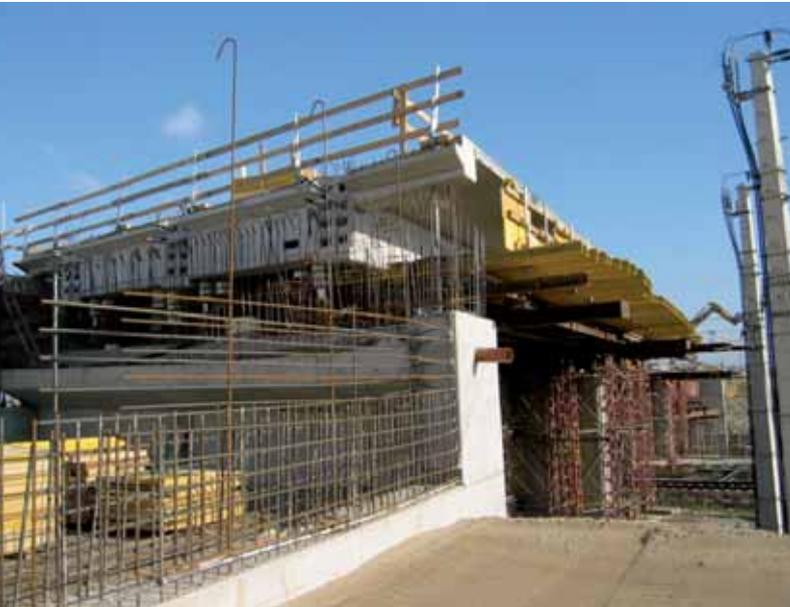
Abb. 11: Objekt 15.258, rechte RFB Tragwerk in erhöhter Lage + 75 cm; 12/03
