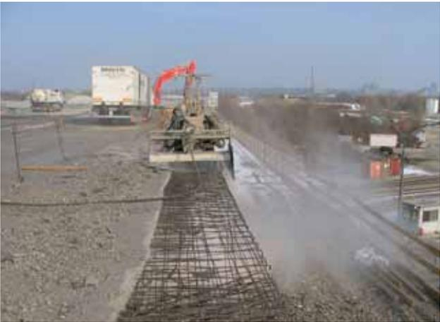
Abb. 16: HDW-Abtrag Tragwerk Brücke OMV; 02/04
