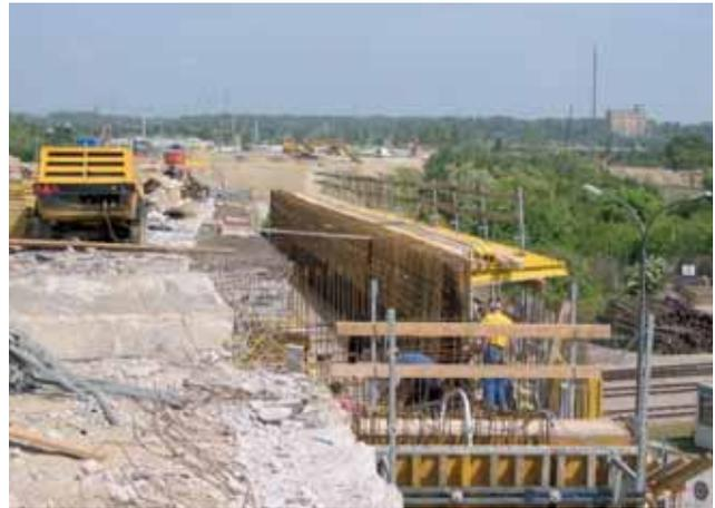
Abb. 17: Brücke OMV, Schalung Träger 6; 05/04
