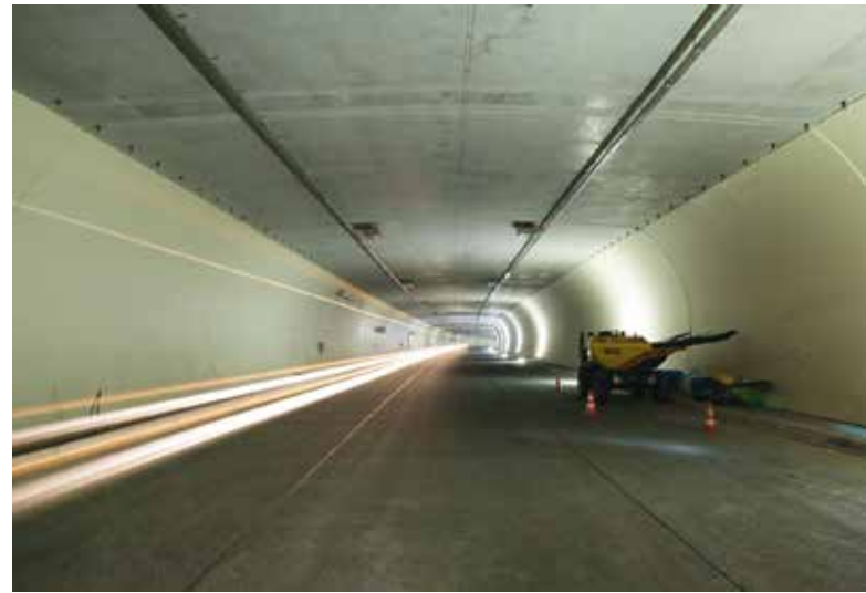
Tunnel Götschka Innenausbau
