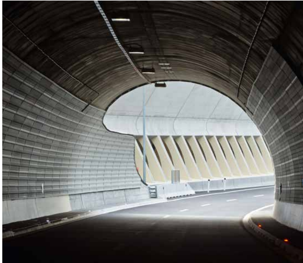
Galerie Brandstätter aus dem Tunnel Manzenreith
