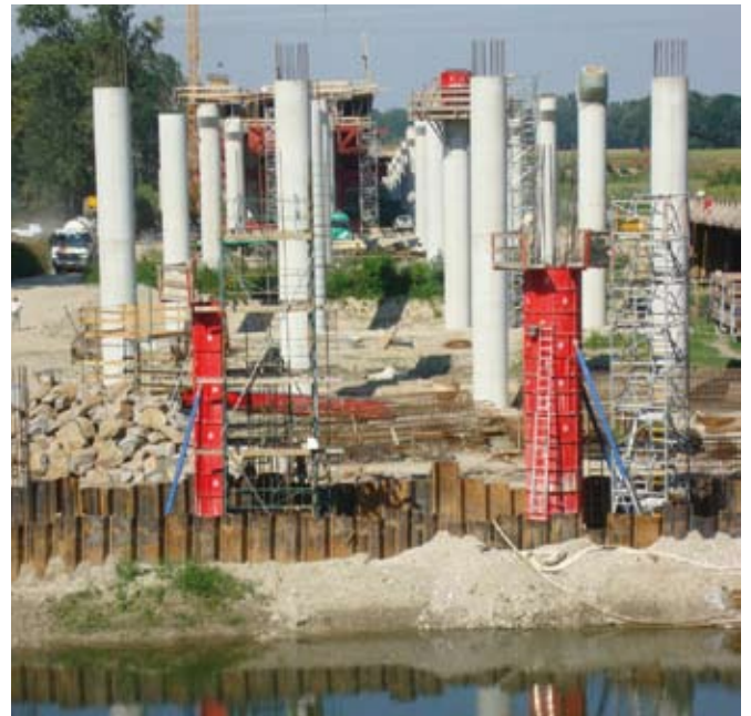
Vorlandbrückenpfeiler Süd C35/45/B4
