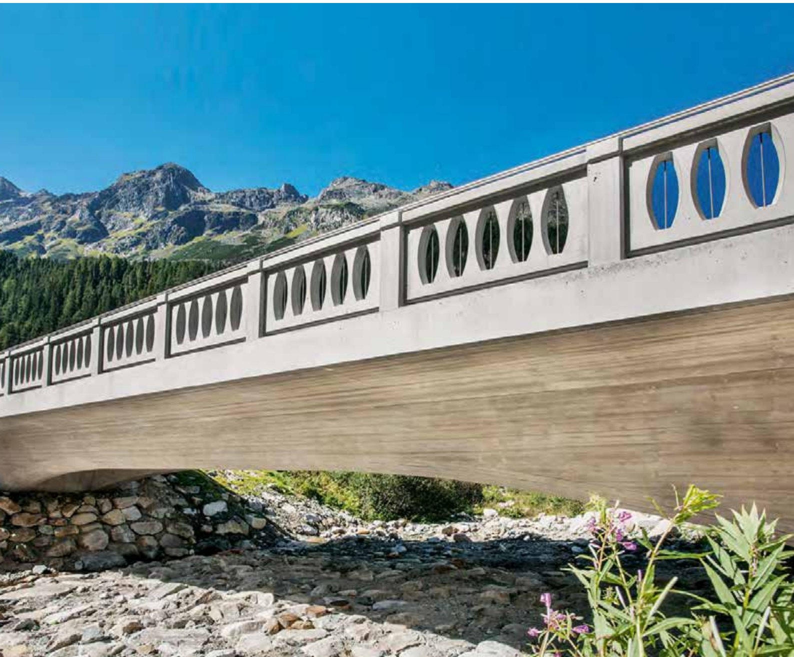
Tauernmoosbach-Brücke nach der Fertigstellung, Foto Sulzer
