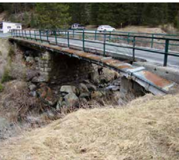
Bild 1: Alte Stahlträgerbrücke
