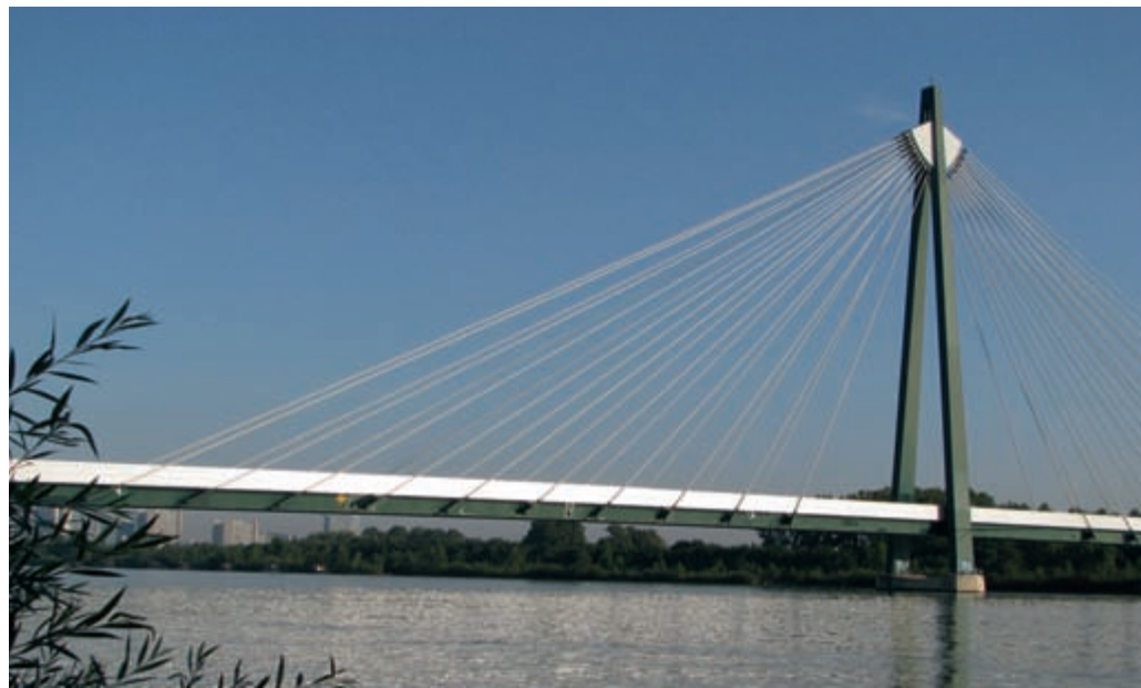
Donaustadtbrücke Endzustand für U-Bahn-Betrieb mit zehn Schrägkabeln
