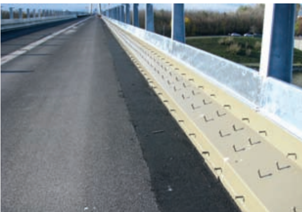
Schalblech für Randbalkenbeton
