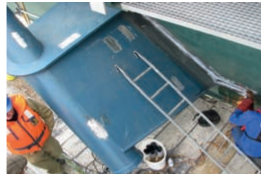
Konsolen für die neuen Kabel werden an das Tragwerk angeschweißt.
