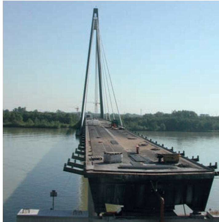
Vorbereitete Brückenverbreiterung
