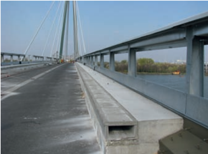
Betonierter Randbalken aus Leichtbeton als Begrenzung für den Gleisschotter
