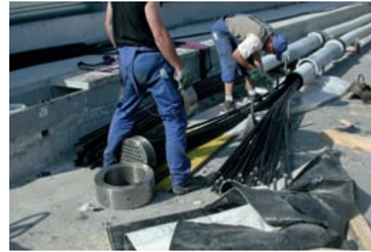
Vorbereiten der Kabel auf dem Brückendeck
