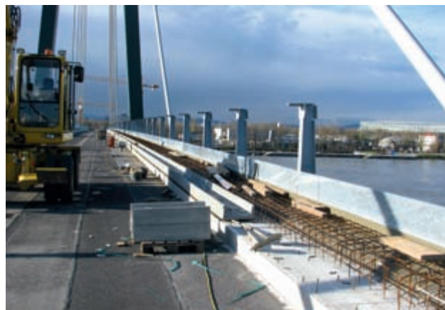
Betonieren Randbalken (Leichtbeton) und Versetzen der Kabeltröge
