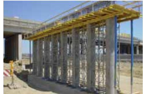
Abb. 10: Herstellung Stützenreihe West Objekt A2.U01
