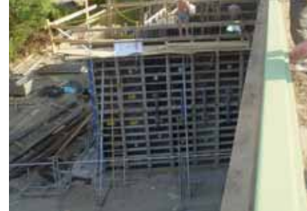
Abb. 17: Schalung Widerlagerverbreiterung
