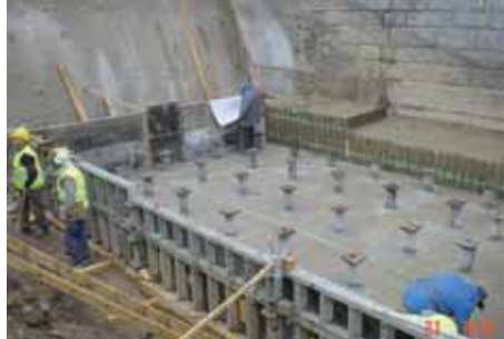
Abb. 16: Gründung Widerlagerverbreiterung
