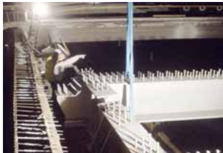
Abb. 19: Montage Stahltragwerk alle Fotos außer 18: Eckhart
