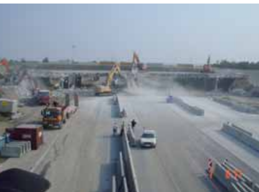
Abb. 22: Abbruch Objekt A2.Ü01
