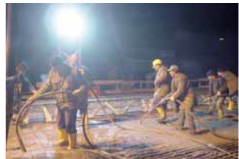
Abb. 13: Betonierung Tragwerk A2.U03
