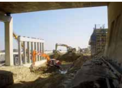
Abb. 11: Herstellung Stützenreihe und Absenkung A2 Objekt A2.U03
