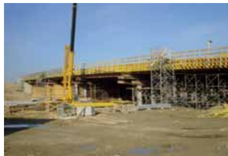
Abb. 12: Tragwerksrüstung Objekt A2.U03
