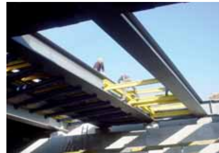
Abb. 20: Schalung Fahrbahnplatte
