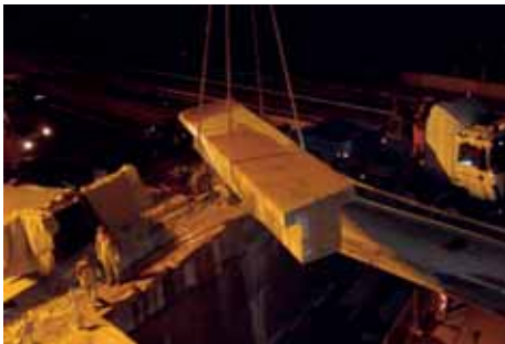
Abb. 18: Abtrag Tragwerk Foto: Tecton Consult, Fr. Prokop
