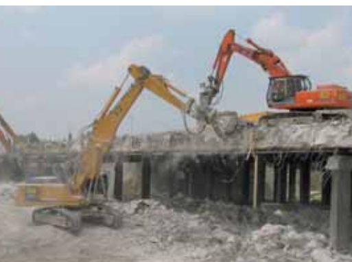
Abb. 23: Brücke über die A2 Südautobahn
