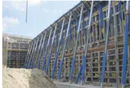
Abb. 9: Schalungsarbeiten Widerlager West Objekt A2.U03
