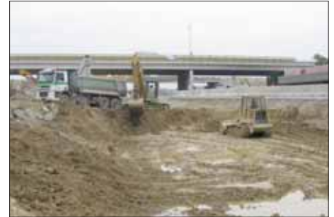
Abb. 2: Absenkung der Südatobahn – Bauabschnitt A1
