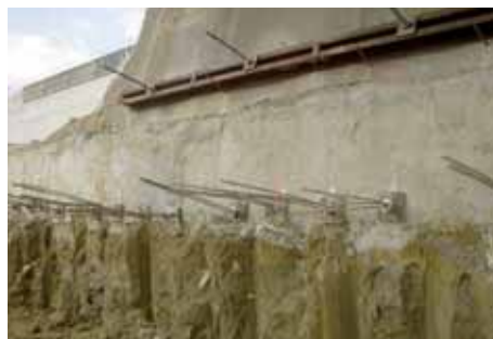
Abb. 6: Sicherungsschlitzwand Widerlager West
