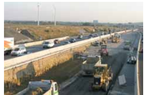
Abb. 3: Absenkung der Südatobahn und Planungsarbeiten – Bauabschnitt A2 Fotos: Stumpf
