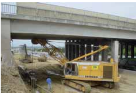
Abb. 4: Sicherungsschlitzwand Widerlager West alle Fotos außer 7: Eckhart
