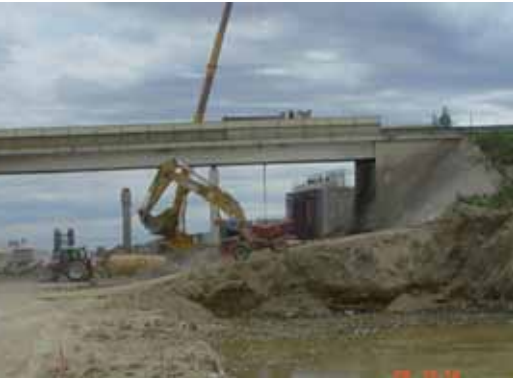
Abb. 21: Anstehender Baugrund im Absenkungsbereich alle Fotos: Eckhart
