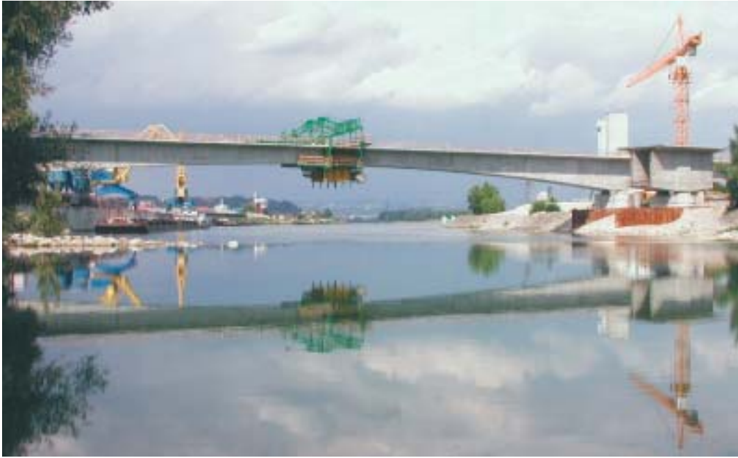
Bild 2: Flussbrücke der Straße – Objekt E 6, Juni 2003 Foto: KMP
