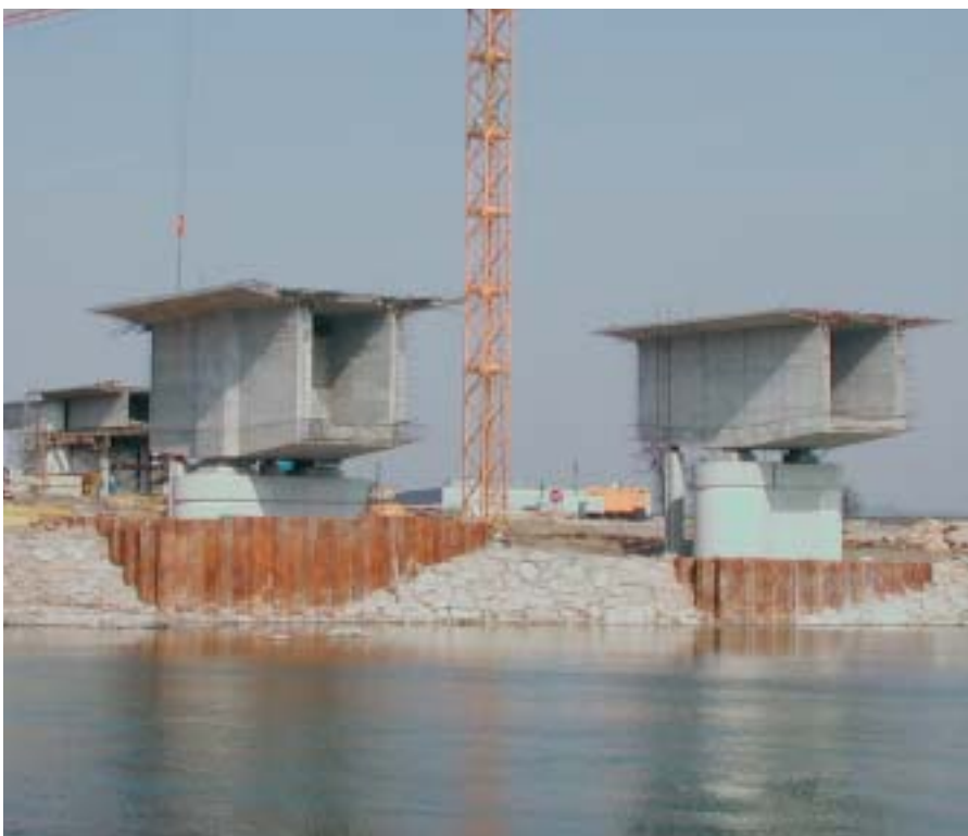
Bild 3: Vergleich der Pfeilerköpfe, März 2003, links Bahnbrücke, rechts Straßenbrücke
