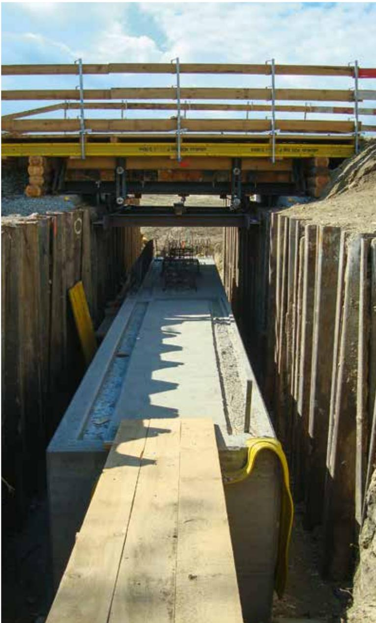
Im Juli 2014 konnten die vier Bahntagwerke in einer weiteren zehntägigen Gleissperre eingeschoben und für den Bahnverkehr freigegeben werden.
