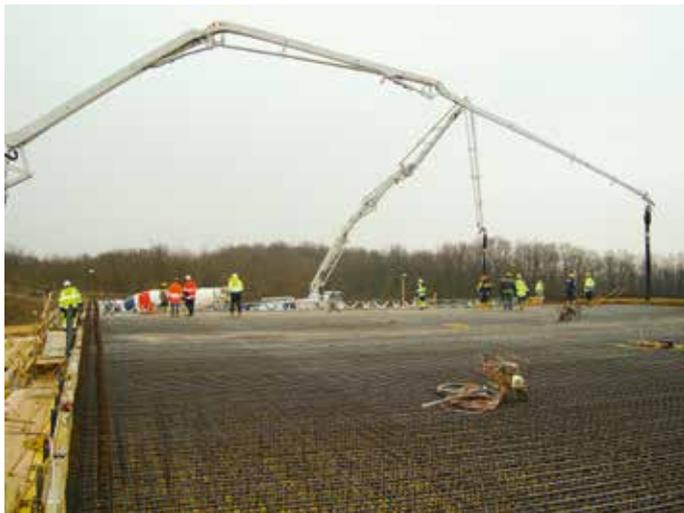
Tragwerksbetonierung Obj. MI.Ü06 Objekt: MI.Ü06 – Wildbrücke über die B46
