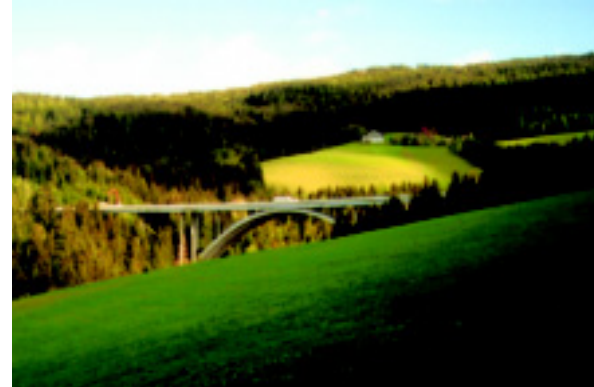
Bild 1: Nießenbach-Brücke der A2 Südbahn, Graz – Klagenfurt Fotos: Klaus Vennemann; Hilti
