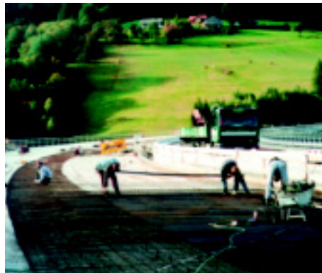
Bild 3: Die Bewehrung für diese Etappe ist beinahe fertig gelegt.
