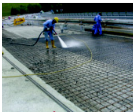
Bild 5: Reinigen und Wässern der Betonierfuge vor dem Betonieren
