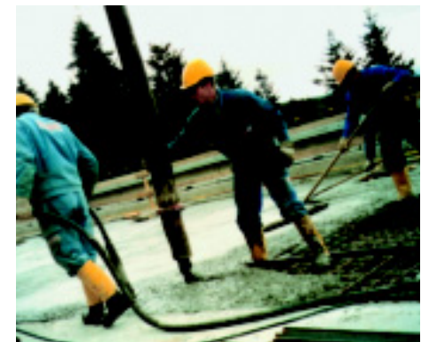
Bild 4: Das Betonieren stellt höchste Ansprüche an alle Beteiligten.
