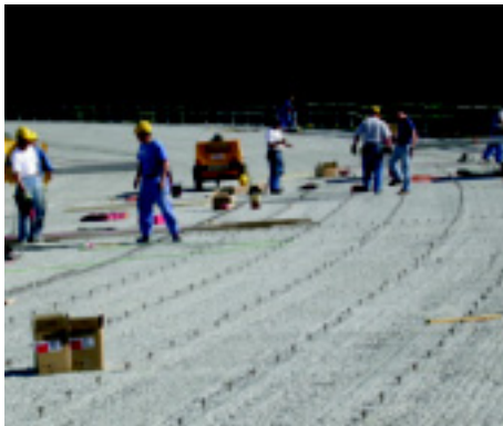
Bild 5: Reinigen und Wässern der Betonierfuge vor dem Betonieren
