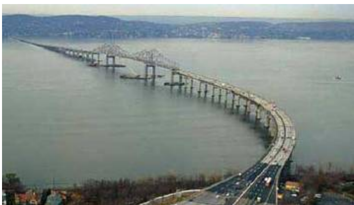
Bild 7: Brücke in USA
