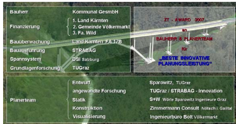
Abbildung 1 Umsetzung des Projekts WILD-Brücke
