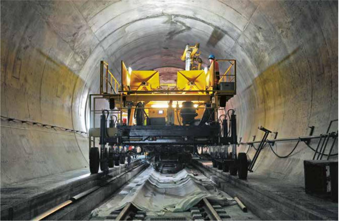
Abbildung 13: Das Betonshuttle fährt auf dem Tunnelbankett ©TTG
