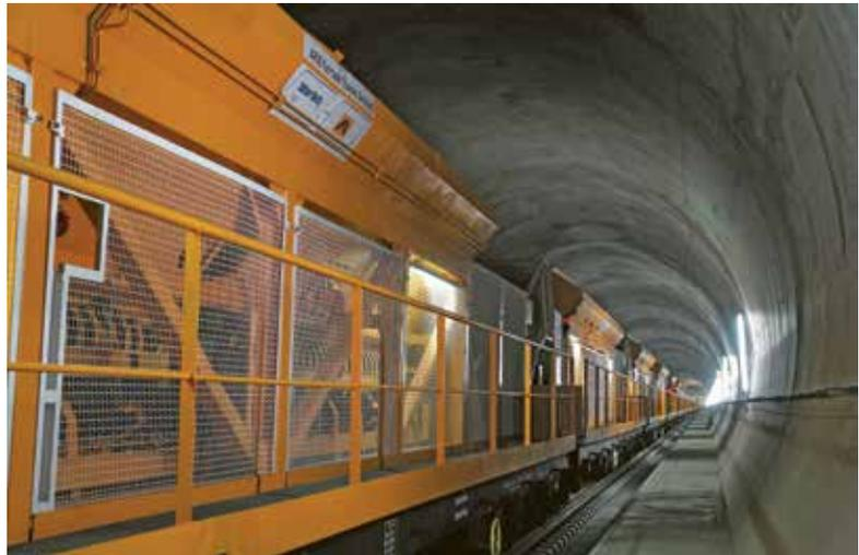
Abbildung 11: Die Zuschlagstoffwaggons des Betonzuges © AFTTG
