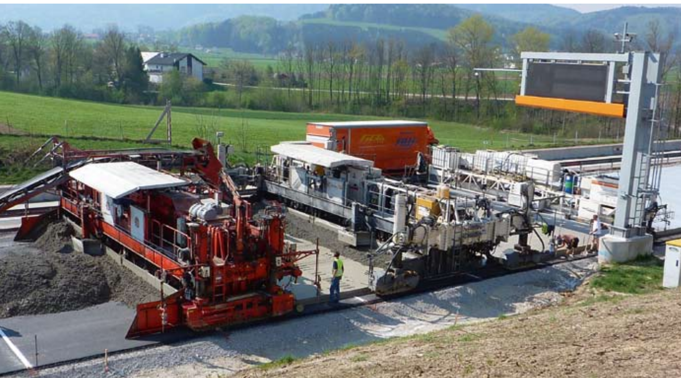
Betoneinbauzug bei Abfahrt Schörföling
