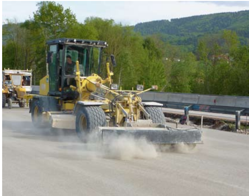
Ausbürsten der Betondecke für Waschbetonstruktur
