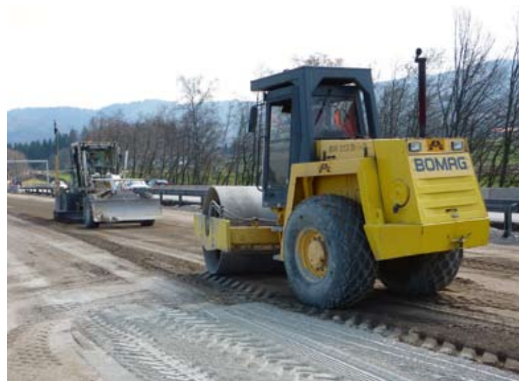
rechts: Verdichtung durch 16-Tonnen-Walze links: 3D-gesteuerter Gräder
