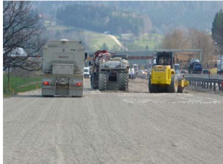
links: Zementvorlage durch Streumeister 2000 rechts: Paralleler Einbau der Fräse
