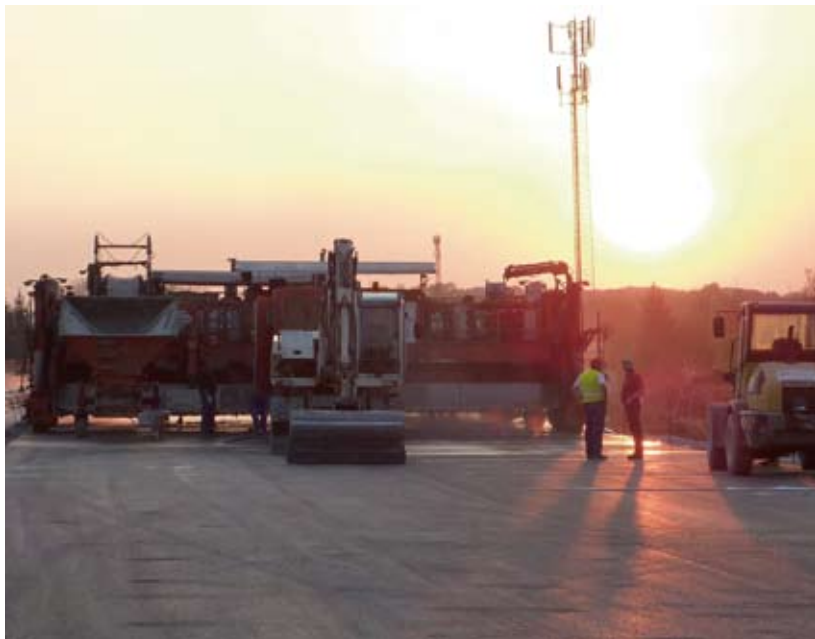
Unterbetonfertiger vor Arbeitsbeginn
