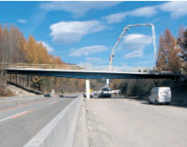
Abb. 11: Neubau eines Überführungsbauwerkes in Stahlverbundbauweise
