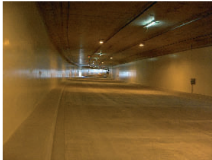
Abb. 5: Einhausung Trebesing, zwei Fahrstreifen plus Pannestreifen
