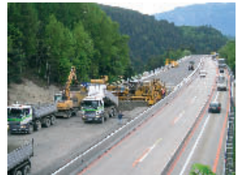
Abb. 2: Betondeckeneinbau mittels Gleitschalungsfertiger
