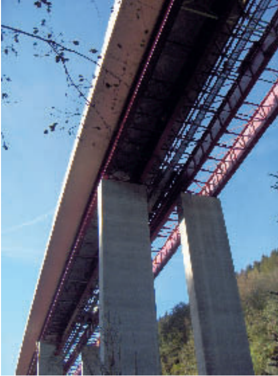
Abb. 6: Brückenobjekt L40 mit abgetragener Tragwerkshälfte Fotos: © Strabag AG, ASFINAG
