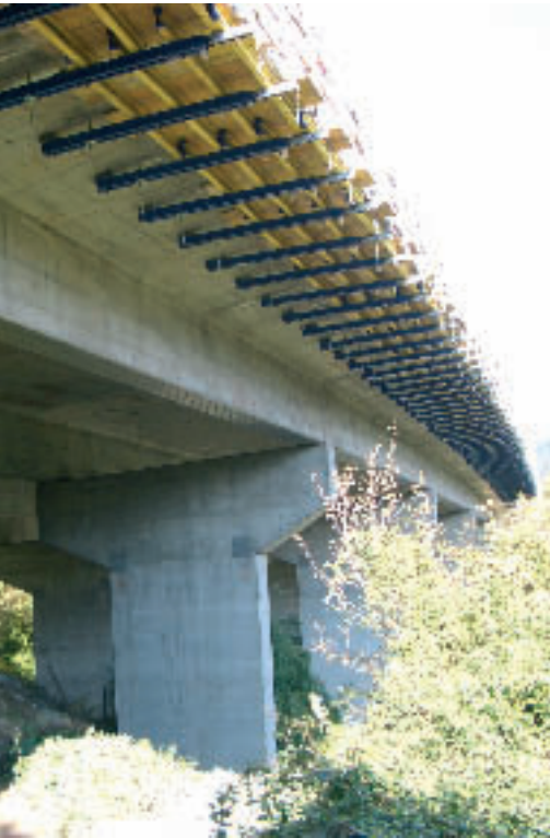
Abb. 8: Kragarmverbreiterung mittels Ausschussrüstung am Brückenobjekt L45
