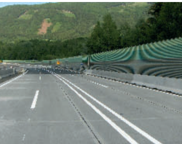
Abb. 12: Lärmschutzwände in Holzbetonbauweise sowie Betonfahrbahn Fotos: © Strabag AG, ASFINAG
