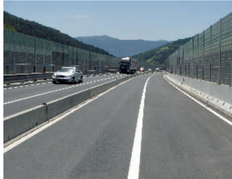
Abb. 13: Trennung der Richtungsfahrbahnen mittels einer durchgehenden Betonleitwand
