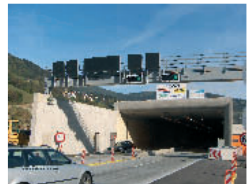
Abb. 3: Einhausung Trebesing Südportal
