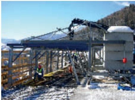
Abb. 9: Kragarmverbreiterung mittels Schalwagen am Brückenobjekt L37
