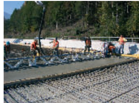
Abb. 10: Aufbetonherstellung bei Brückenobjekten zur Erhöhung der Tragfähigkeit Fotos: © Strabag AG, ASFINAG
