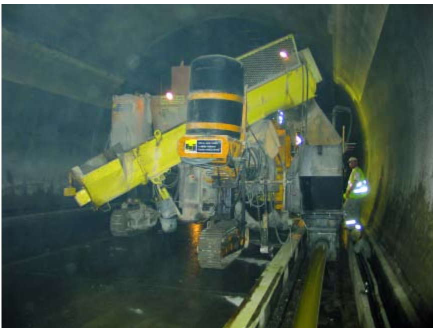
Der Schlauchdurchmesser definiert den Rinnenquerschnitt
