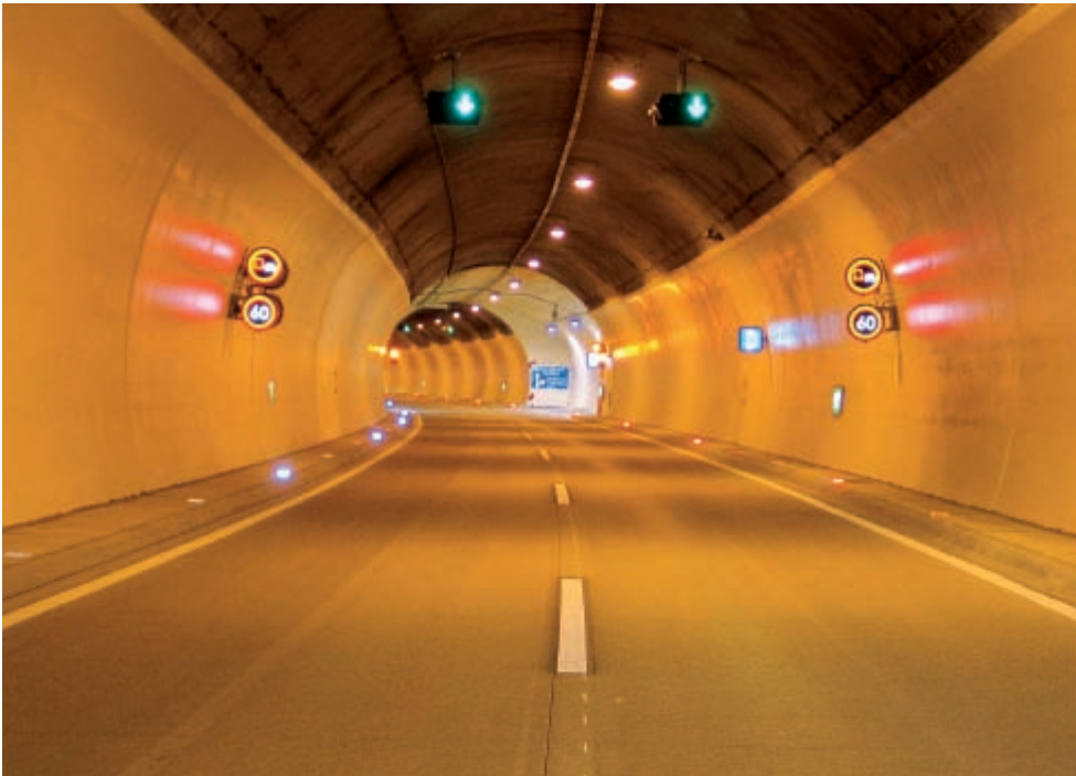
Der Ambergtunnel nach der Sanierung Fotos: Ing. Markus Luger, Amt der Vorarlberger Landesregierung
