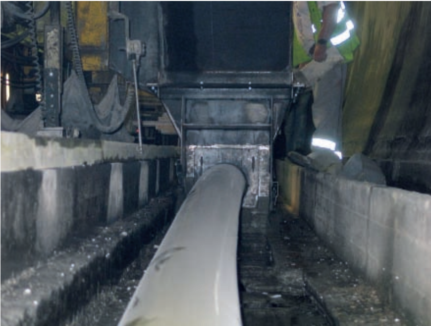
Die Verwendung eines Schlauches als Schalungselement
