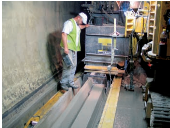
Rinnenherstellung mittels Gleitwagen
