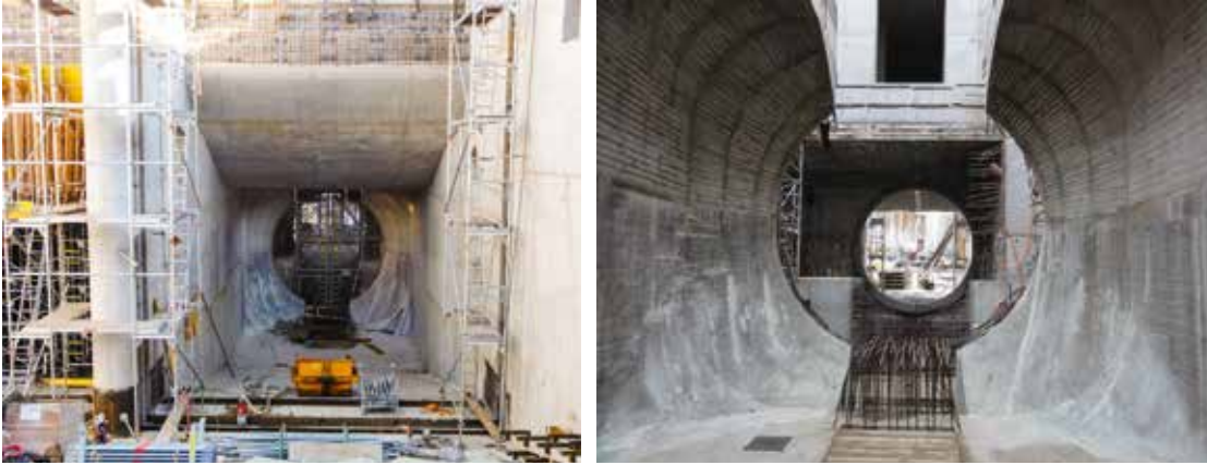
Abbildungen 5, 6 und 7: Einlauf- und Saugrohrbereich des Triebwasserweges
