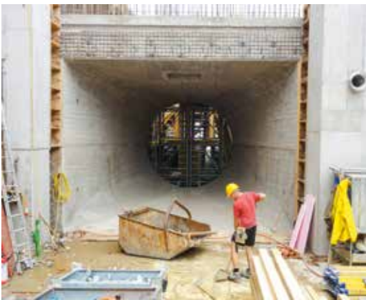
Abbildungen 5, 6 und 7: Einlauf- und Saugrohrbereich des Triebwasserweges
