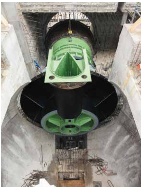
Abbildungen 8 und 9: Der Sekundärbetonbereich
