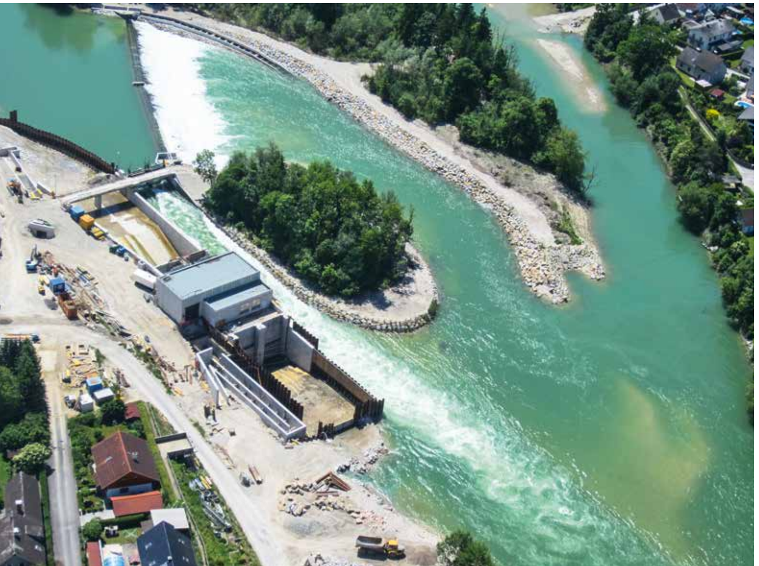
Abbildung 1: Übersicht Krafthaus und Wehranlage
