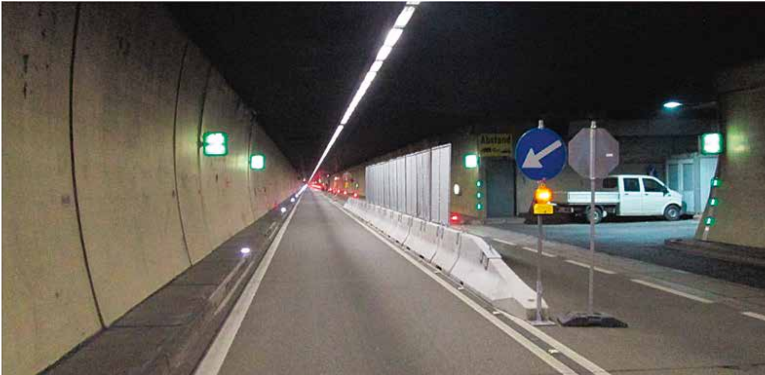
Abgesicherter Baustellenbereich bei wechselseitigen Portalanhaltungen in Phase I
