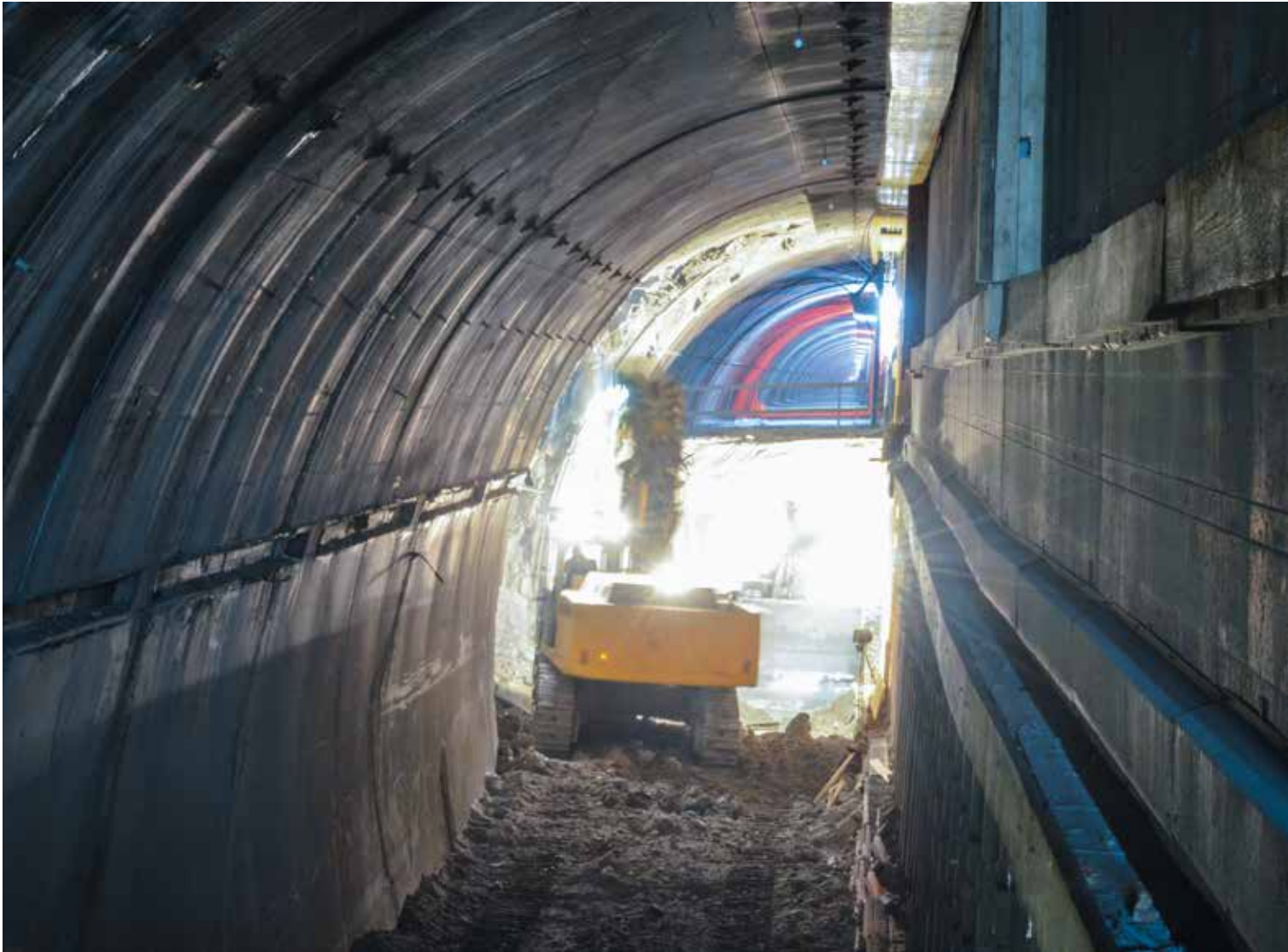
Ausbrucharbeiten neue Pannenbuchten
