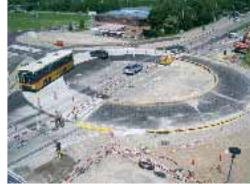
Uster Nord ZH im Bau
