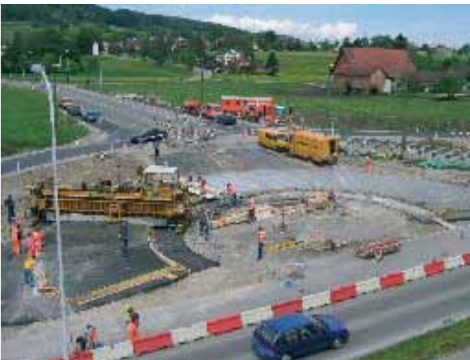
Neftenbach ZH, maschineller Einbau
