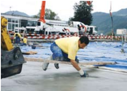
Abtalschieren der Oberfläche von Hand.
