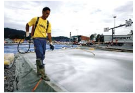
Die Nachbehandlung des Betons beginnt mit dem Aufsprühen eines Curingprodukts. Danach wird er mit Thermomatten abgedeckt.
