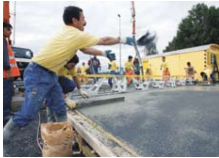
Das Aufstreuen eines Hartstoffs erhöht die Griffigkeit des fertigen Belags.
