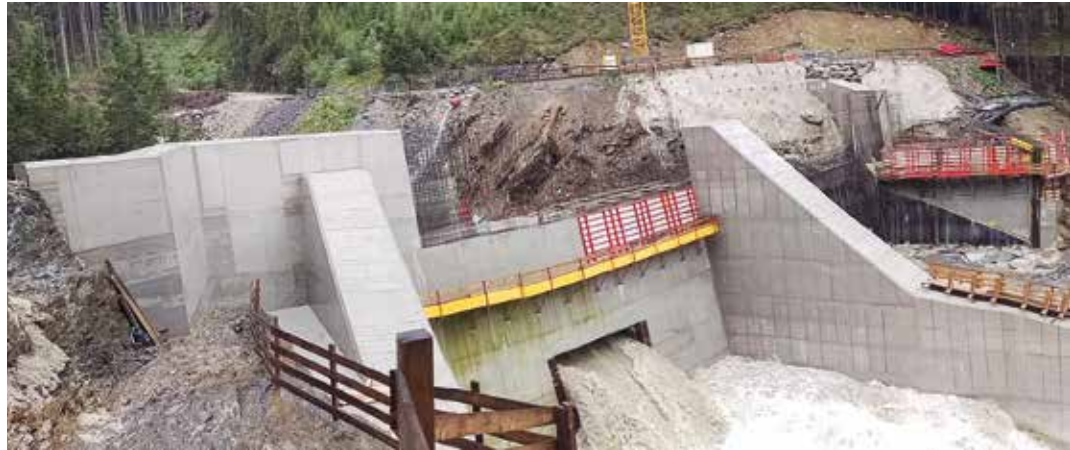
Hochwasserführung während der Bauphase, Entlastung über eine temporäre Öffnung
