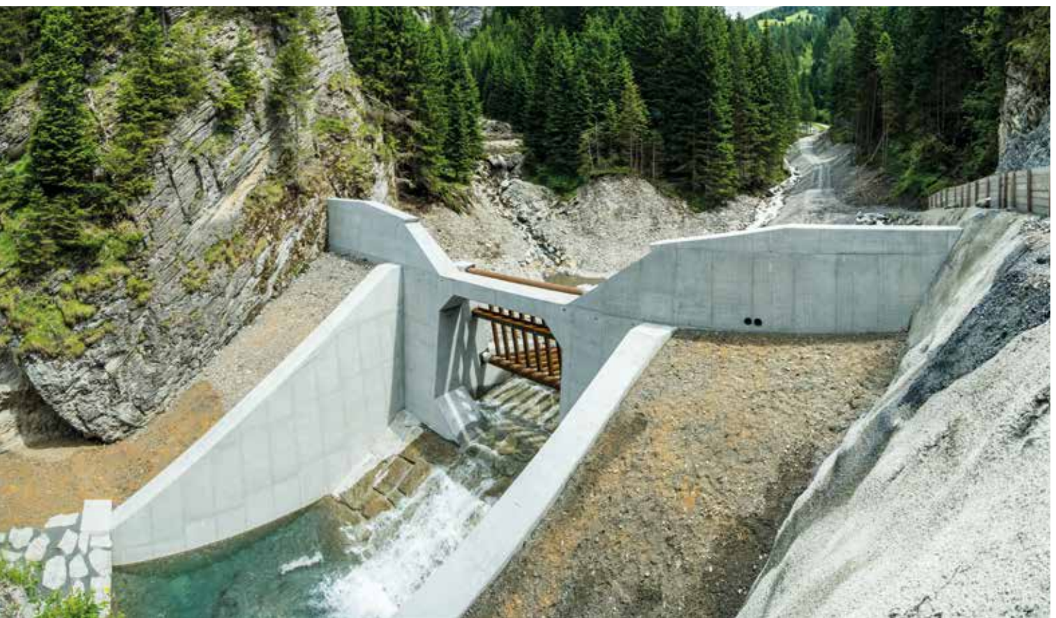
Abbildung 9: Hintere Geschiebesperre mit Zuschlagstoff aus der Materialaufbereitungsanlage
