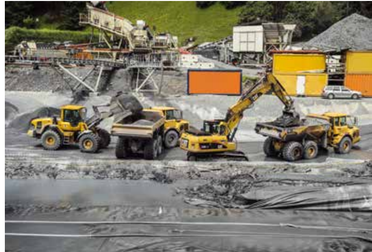
Abbildung 7: Schlammmentwässerung und Verfuhr von Ausbruch
