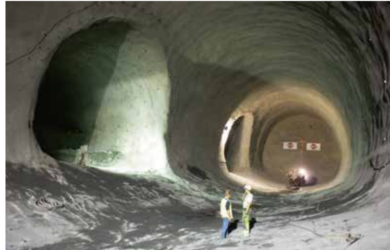
Abbildung 10: Spritzbetonsicherung Abzweigekaverne
