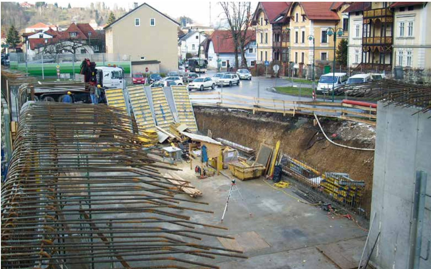
„Offene Bauweise West“
