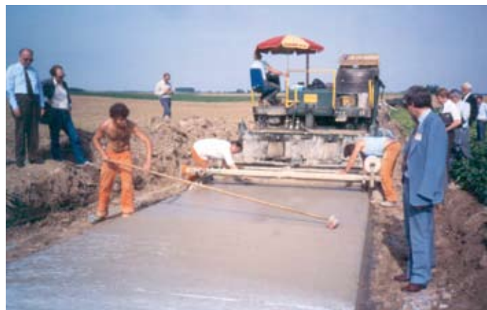
Abbildung 7: Einbau mit Fertiger
