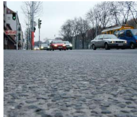
Abbildung 3: Waschbetonoberfläche – Margareten Gürtel Wien, 2007
