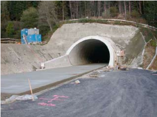
Abbildung 4: Betonfahrbahndecke im Herzogbergtunnel, Südataubahn A2
