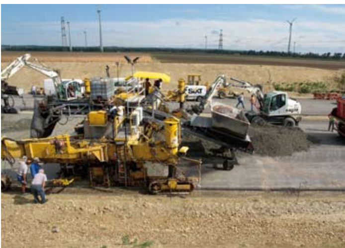
Betonfertiger im Einsatz auf der S1-Ost – Herstellung des Unterbetons (beide Abbildungen)
