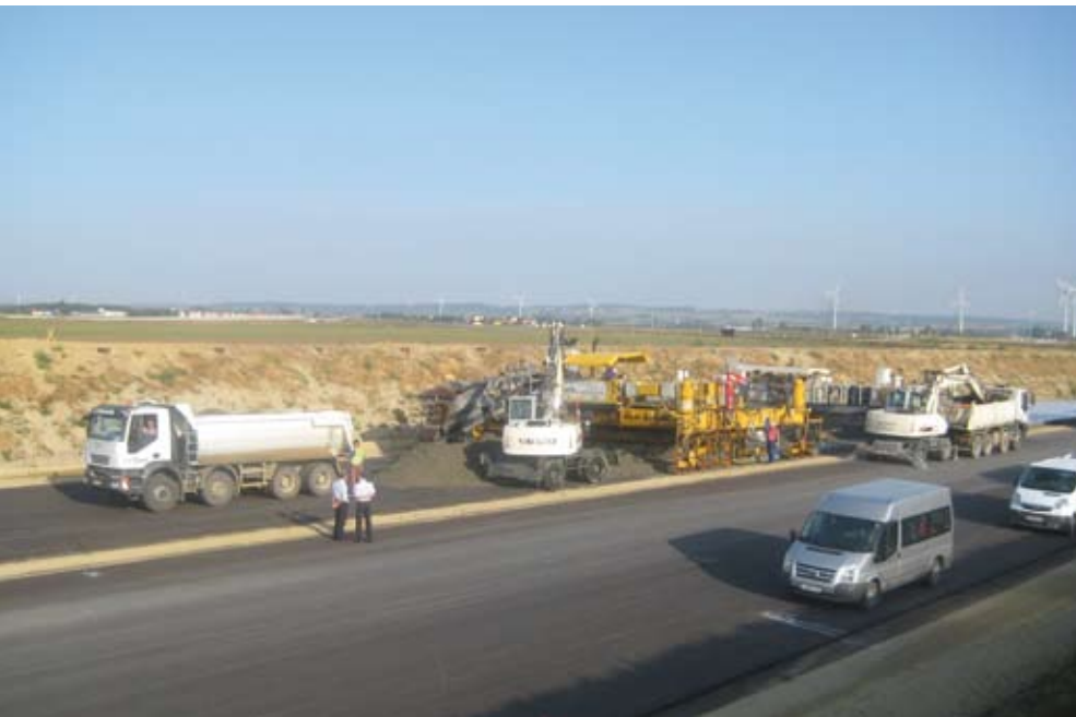
Die Herstellung der Betondecke erfolgt auf einer Asphaltsschicht
