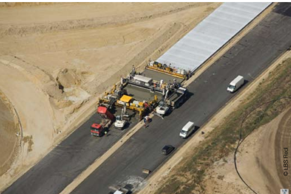
Betonfertigerzug mit Herstellung des Unterbetons, des Oberbetons und Aufbringen des Verdunstungsschutzes
