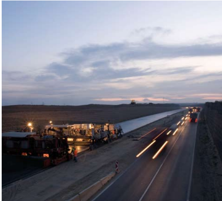
Herstellung der Betondecke für die A5 neben der jetzigen unter Verkehr stehenden B7-Brünner Straße
