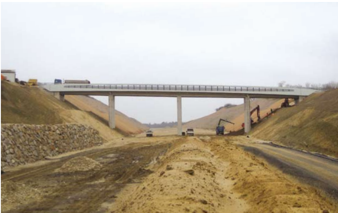
Landesstraßenbrücke A5.Ü08 der L3103 über die zukünftige A5 Nordautobahn mit Corporate Design Elementen
