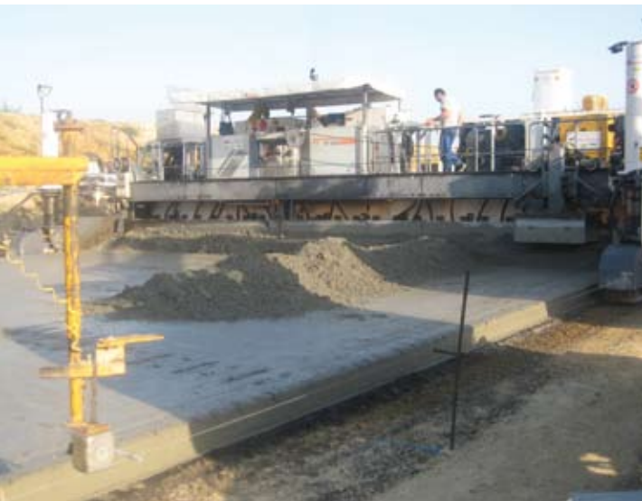
Betonfertiger im Einsatz auf der S1-Ost – Herstellung des Oberbetons (beide Abbildungen)
