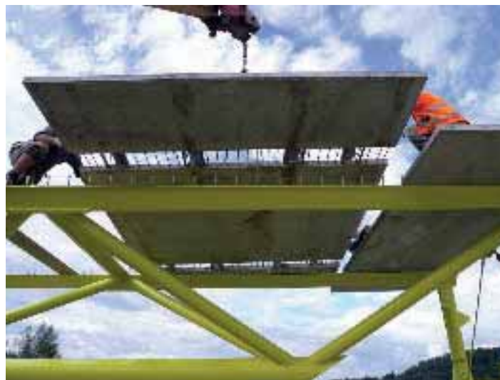
Bild 3.4: b) Verlegung der Fertigteile am Stahlträger
