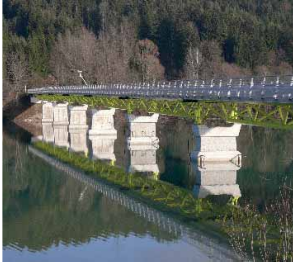
Bild 2.1: Gesamtansicht Draubridge Selkach Neubau
