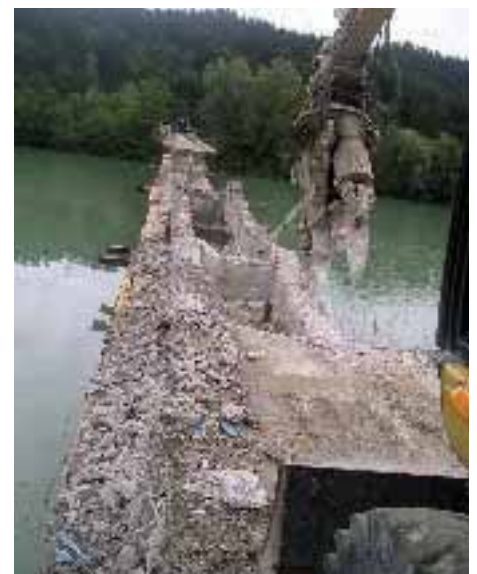
Bild 3.1: Abbrucharbeiten des bestehenden Überbaus
