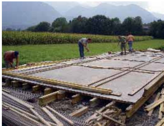
Bild 3.4: a) Herstellen der Fertigteilplatten am Schaltisch vor Ort
