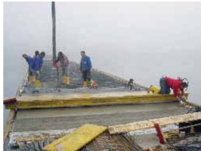
Bild 3.7: Betonieren der Fahrbahnplatte, a) Betonieren
