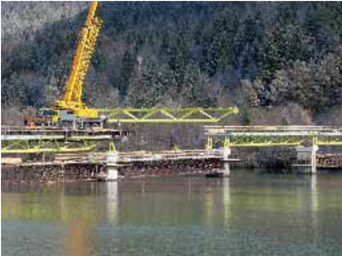
Bild 3.2: Einhub der Fachwerkträger
