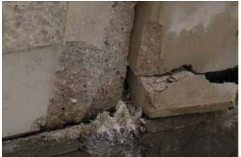
Abb. 6: Starke Abplatzungen bei der Betonleitwand – geringfügige oberflächliche Schäden beim Faserhochleistungsbeton
