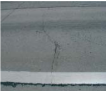
Bei Randfeldern, besonders im Bereich der Entwässerungseinläufe, wird das geometrische Verhältnis 1:1,5 (Breite : Länge) beachtet Fotos: MA 28
