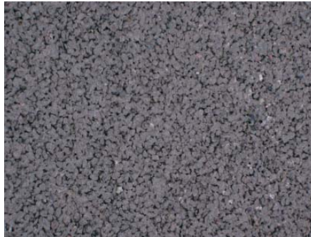
Abb. 14: Beispiel für eine stark lärmindernde Dränbetonoberfläche
