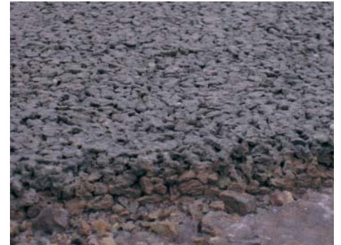
Abb. 14: Beispiel für eine stark lärmindernde Dränbetonoberfläche
