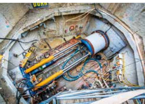
Startschacht der Hydroschildmaschine
