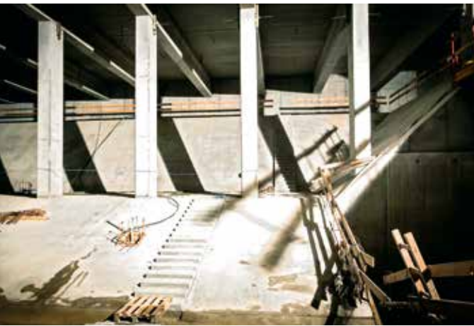
Speicherbecken im Bau
