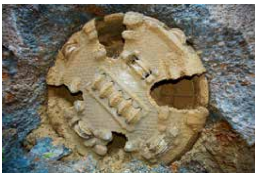
Durchstich im Zielschacht
