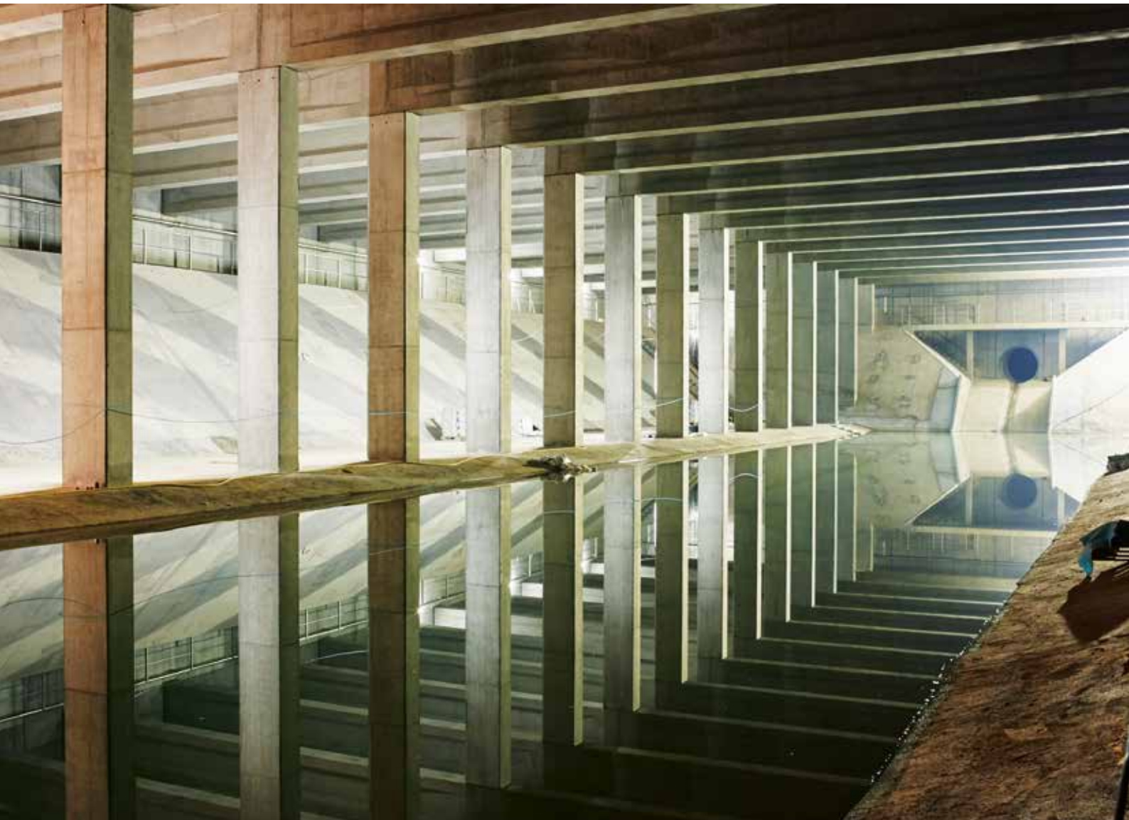
Blicke ins Speicherbecken
