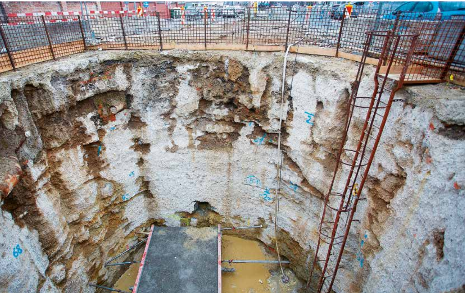
Zielschacht in der Kaiser-Ebersdorfer-Straße
