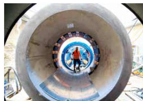
Vier Meter lang, 18 Tonnen schwer; Stahlbeton-Press- und Kanalrohr
