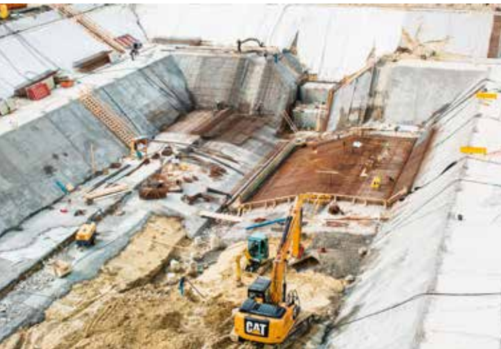
Bau des Speicherbeckens mit 28,5 Millionen Liter Fassungsvermögen
