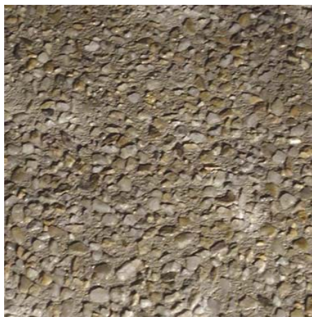
Abbildung 8: Waschbetonoberfläche mit heller Gesteinskörnung [Foto VÖZFI]
