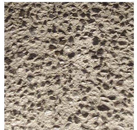
Abbildung 9: Waschbetonoberfläche mit dunkler Gesteinskörnung und der Verwendung von Titandioxid [Foto VÖZFI]
