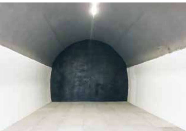
Abb. 1: Für die Messung vorbereiteter Versuchstunnel
