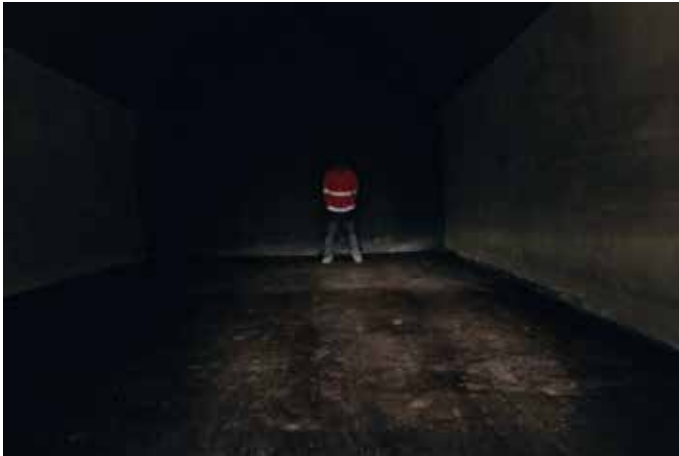
Abb. 3: Unterschiede der Ausleuchtung von Fahrbahnen mit Asphalt- bzw. hellen Betonoberflächen
