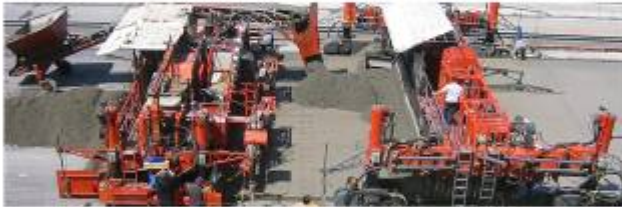
Straßen Betondeckenbau 12.000.000 m 2
