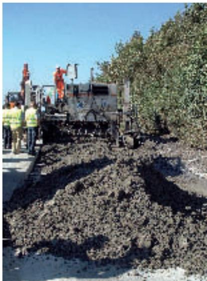
Extrem steifer Beton kommt zum Einsatz.
