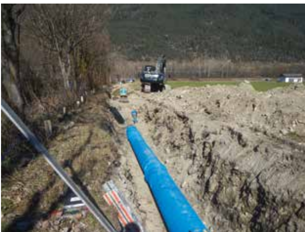
Druckrohrleitung
