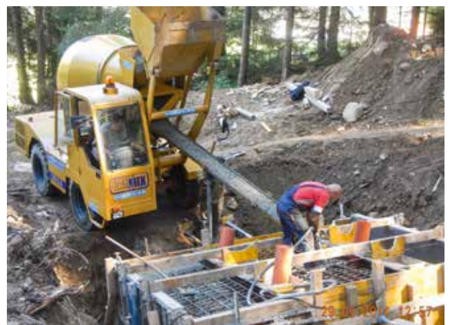
Druckrohrleitung: Betonfixpunkt
