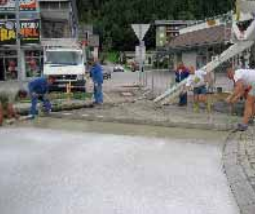
Abb. 5: Händischer Einbau
