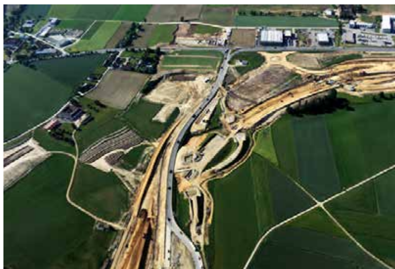
Luftbild Trasse nördlicher Teil im Rohbau
