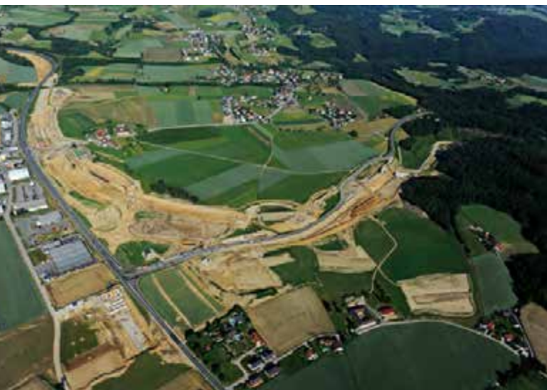
Luftbild gesamte Trasse im Rohbau
