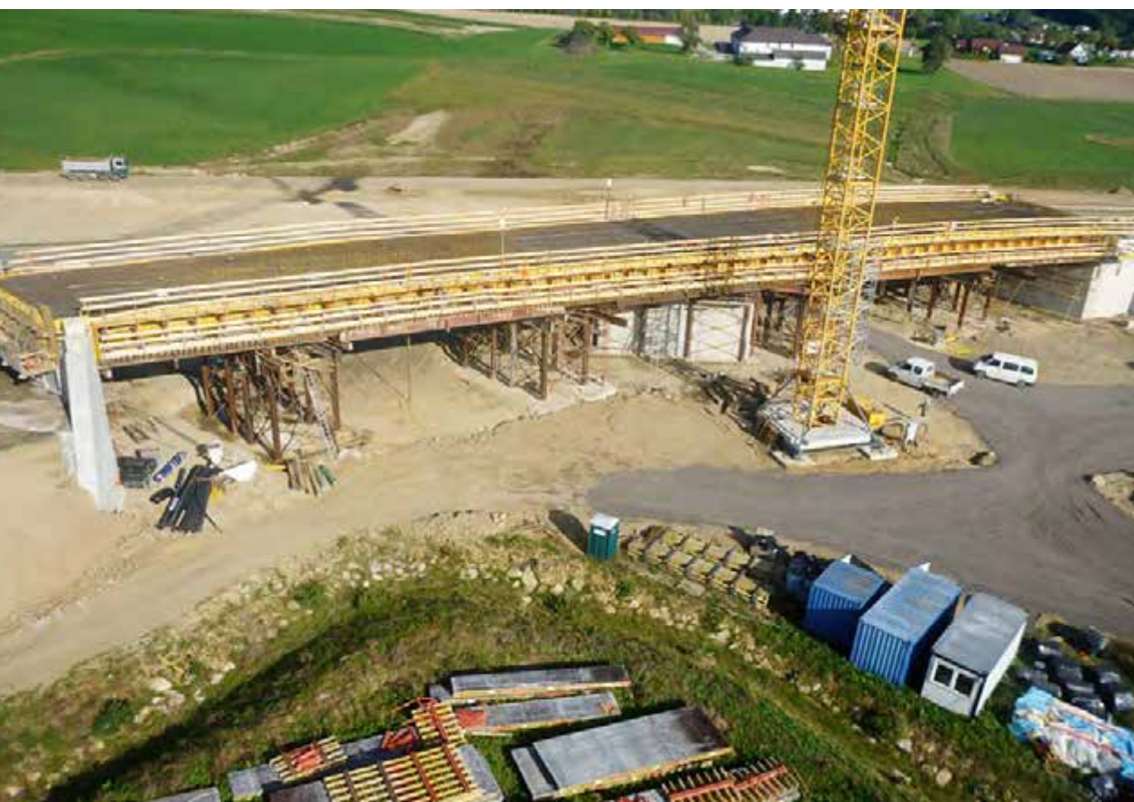
2-feldriges integrales Bauwerk, Gesamtstützweite 83 m
