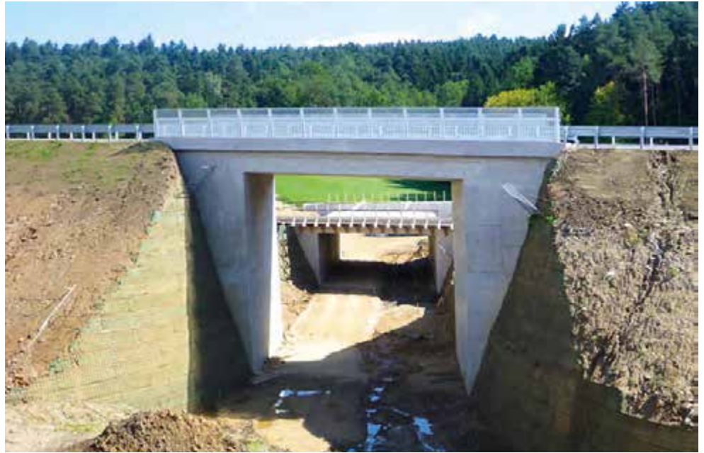
S-10-Objekte mit Steilböschungen aus bewehrter Erde
