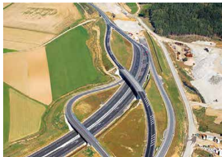
Bereits seit Herbst 2012 in Betrieb: der Abschnitt Unterweikersdorf im Süden der S 10
