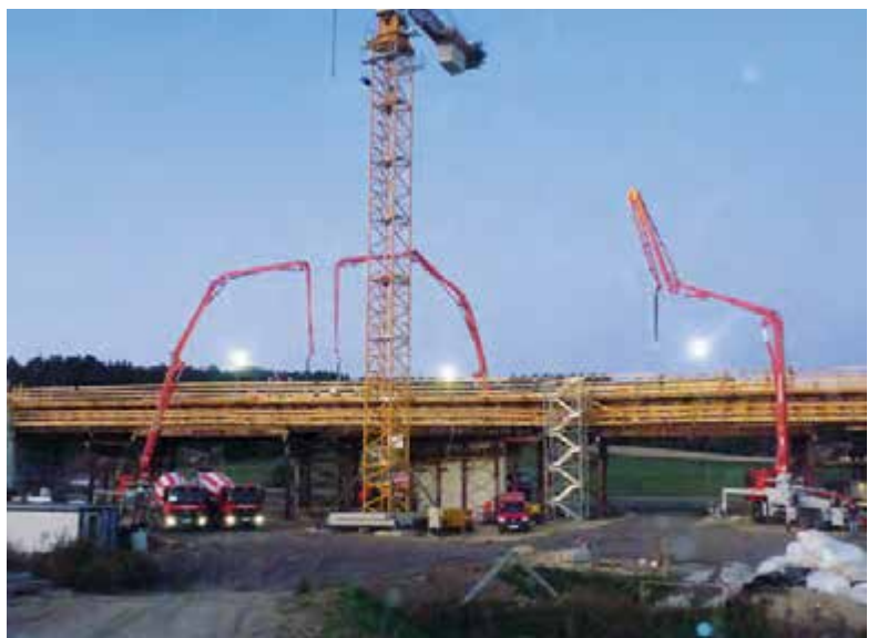
Tragwerksbetonage 1.300 m 3 mit 3 Betonpumpen in 10 Stunden
