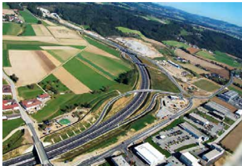
Luftbild gesamte Trasse im Rohbau
