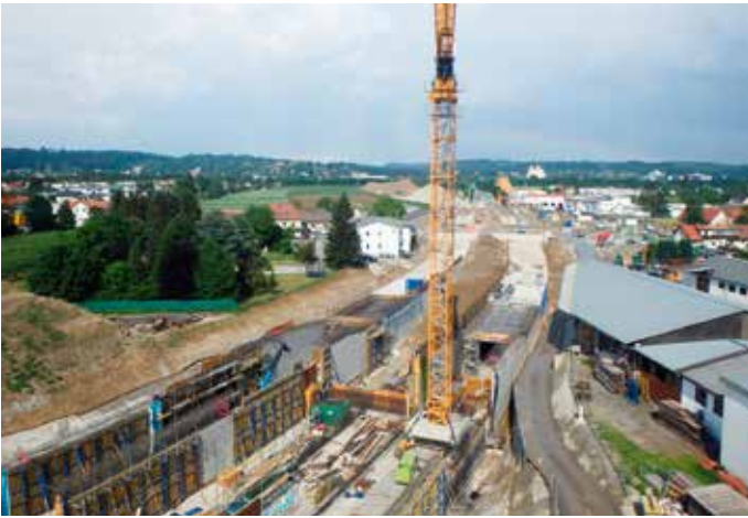
Ein- und Ausfahrtsbereich, aufgelöster, getrennter Tunnelquerschnitt
