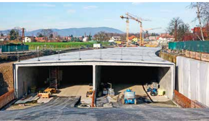
Regelabschnitt Beginn (Schalwagen), Betonbau fertig
