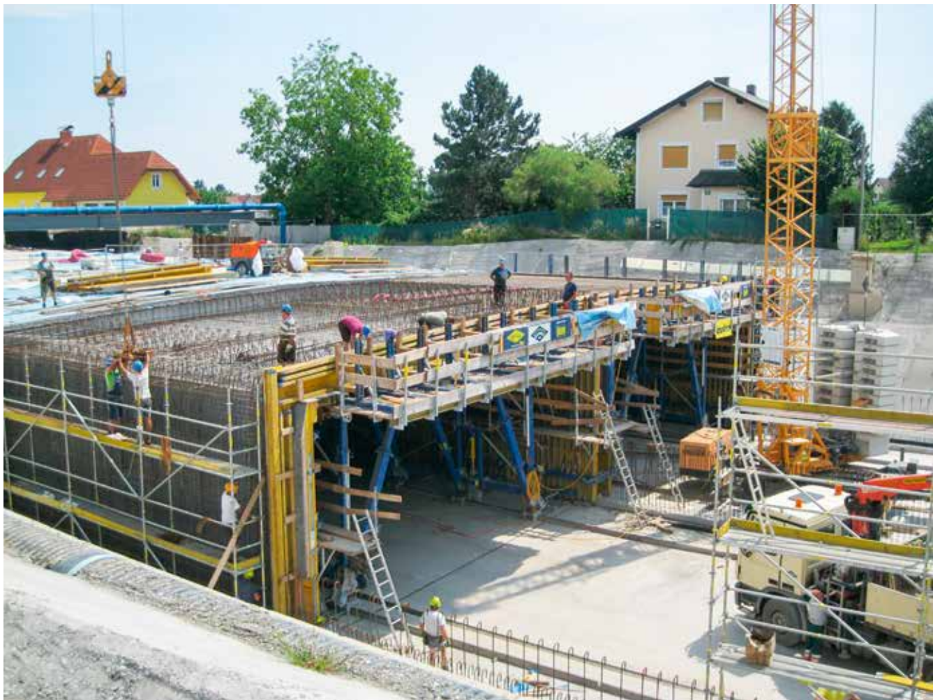
Schalwagen – Regelquerschnitt
