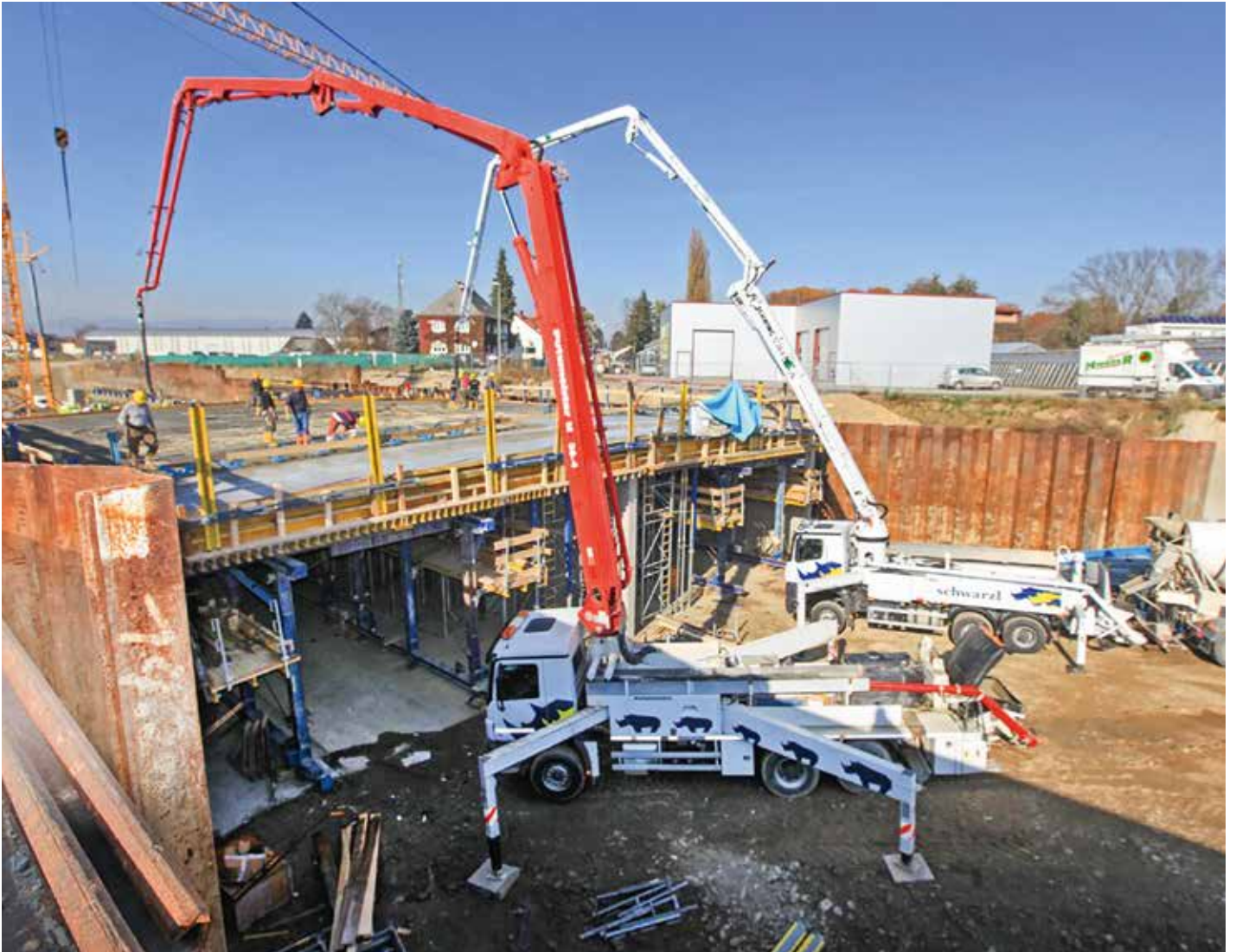
Betonage einer Tunneldecke im Einfahrtsbereich
