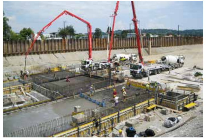
Betonage einer Bodenplatte
