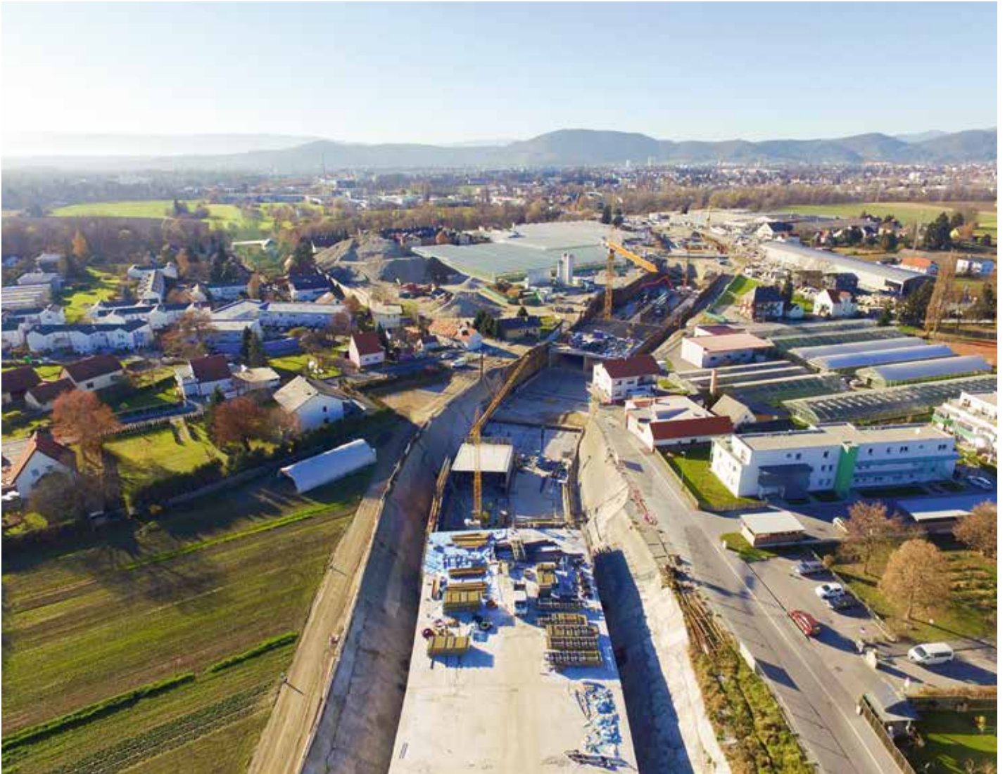
Luftbildaufnahme – Ende des Regelabschnittes, dahinter Einfahrtsbereich West in Arbeit
